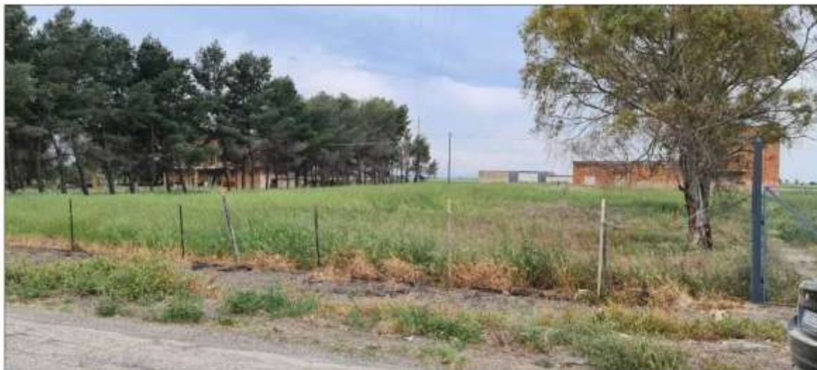
Figura 5-14: Vista dell'impianto - presa PVF04: ante-operam
