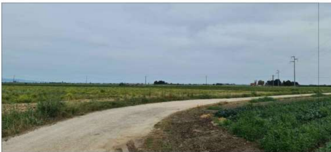
Figura 5-12: Vista dell'impianto - presa PVF03: ante-operam
