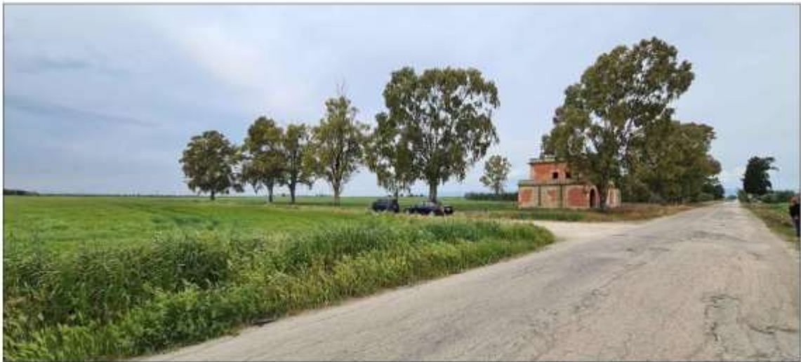
Figura 5-8: Vista dell'impianto - presa PVF01: ante-operam
