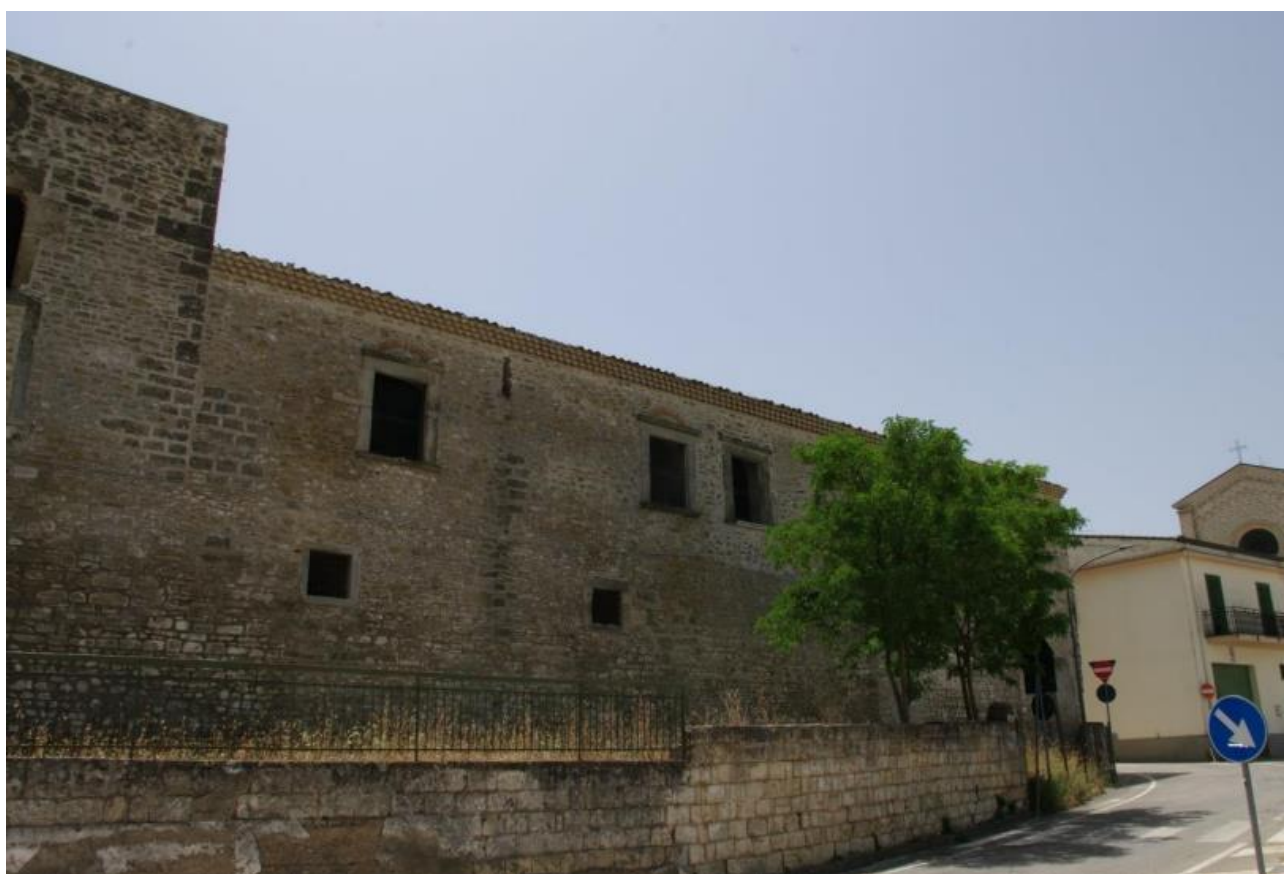
Figura 8-13: Vista Palazzo e chiesa San Nicola
