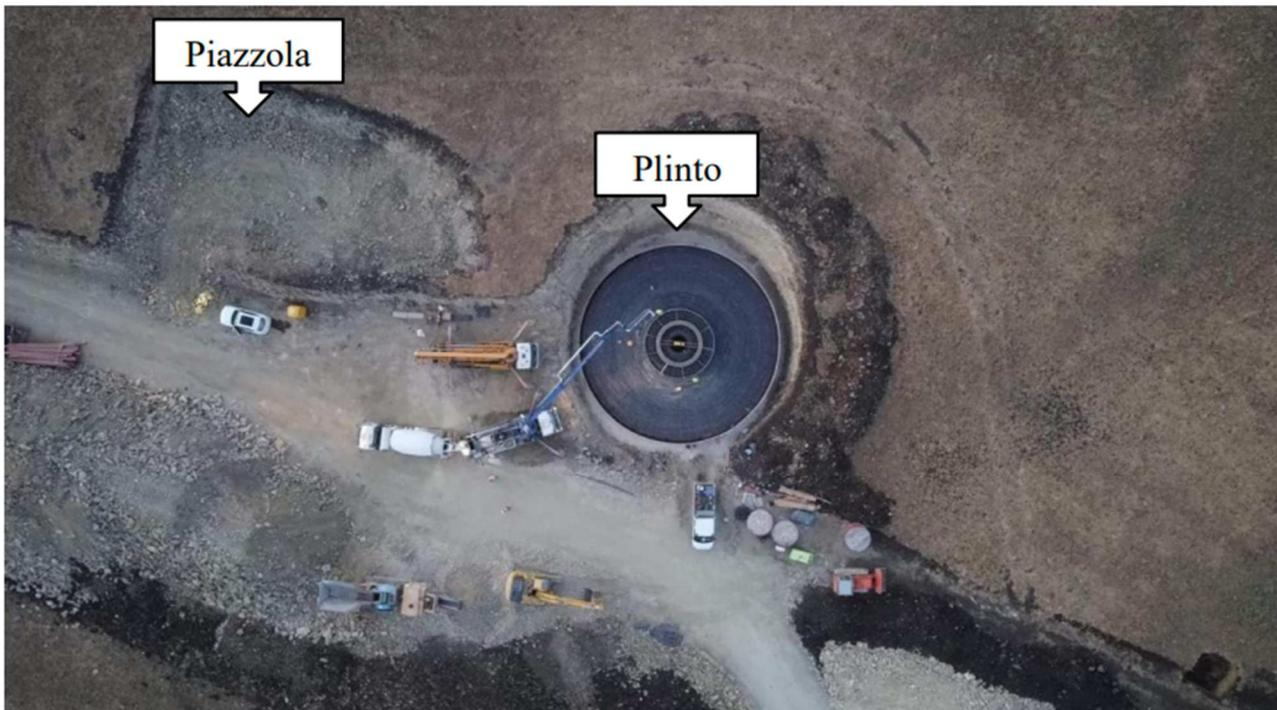
La progettazione delle piazzole da realizzare per l'installazione di ogni aerogeneratore prevede due configurazioni, la prima necessaria all'installazione dell'aerogeneratore e la seconda, a seguito di opere di dismissione parziale, per la fase di esercizio e manutenzione dell'impianto. Le piazzole nelle n. 2 fasi sono riportate nella Figura 3-9.
