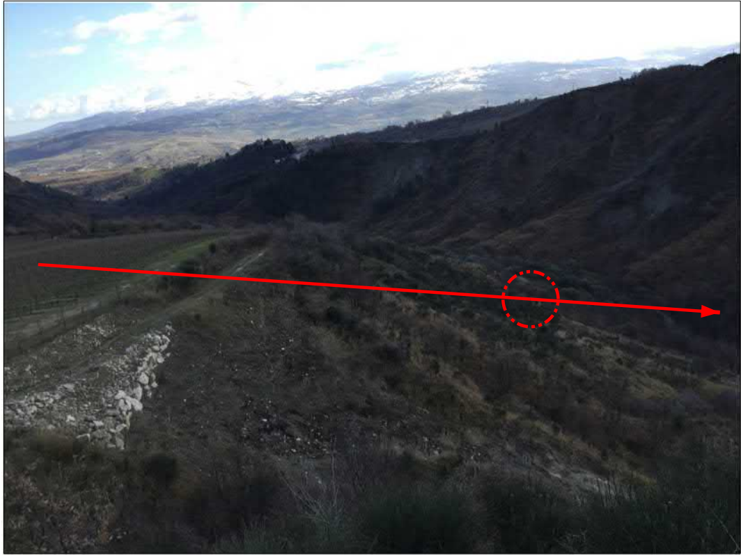
Uscita microtunnel "Colle della Guardia"
