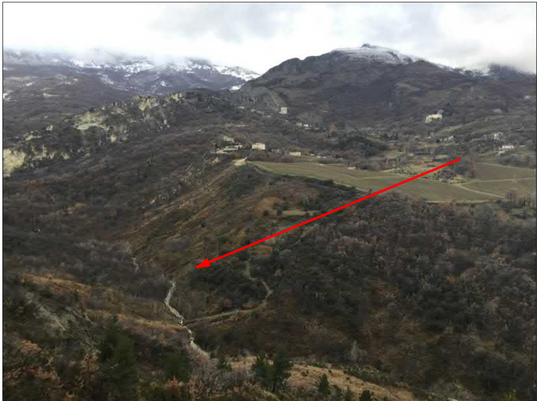
Microtunnel "Colle della Guardia"
