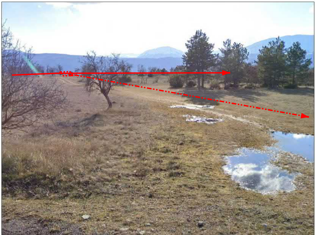
Ricollegamento allacciamento comune di Barisciano
