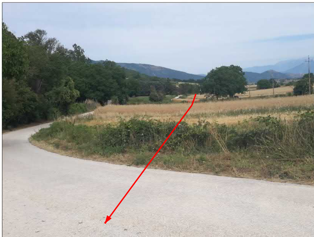
Attraversamento strada comunale
