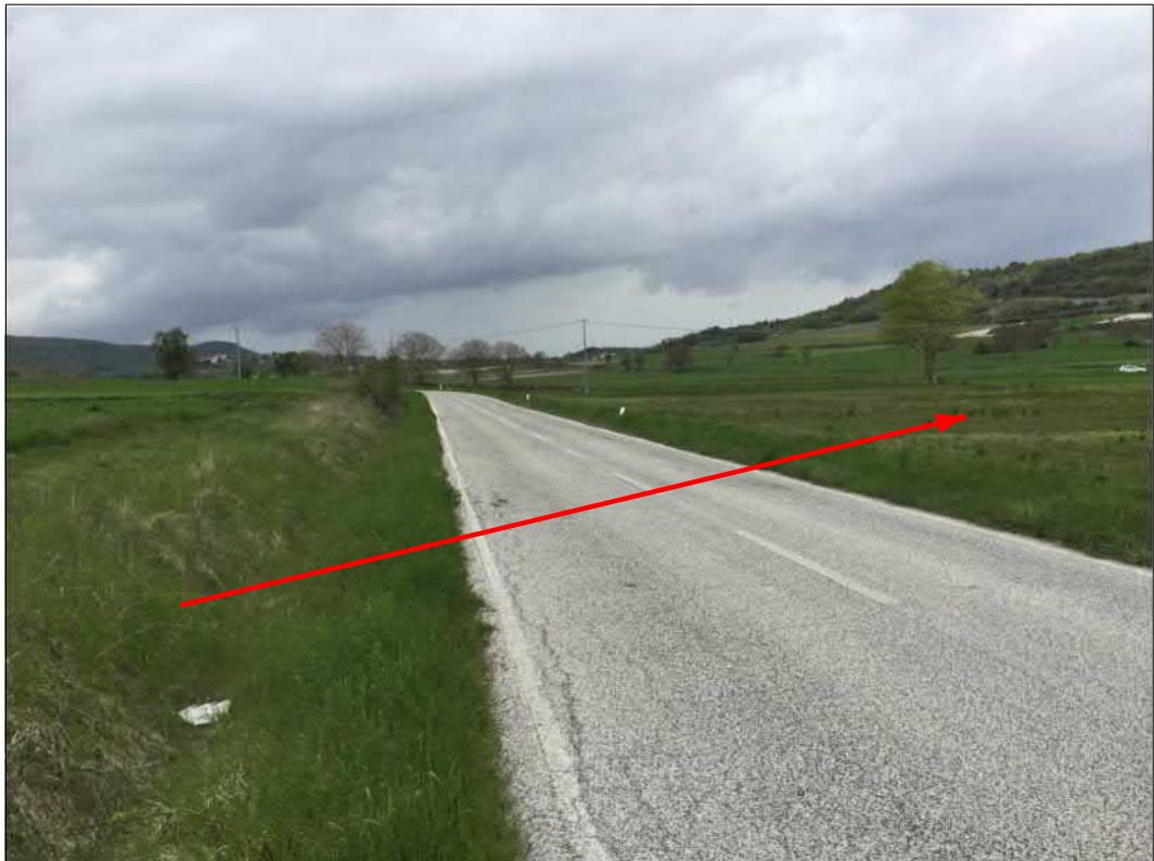
Attraversamento S.P. n.8
