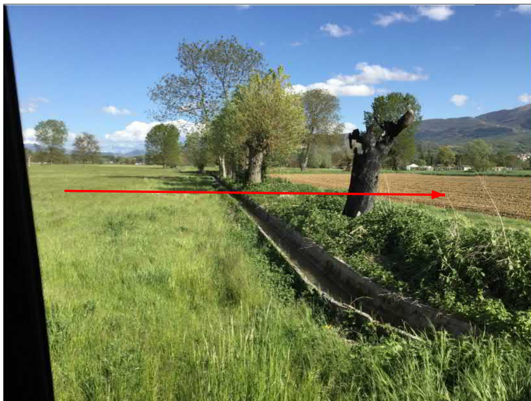
Attraversamento canaletta in calcestruzzo
