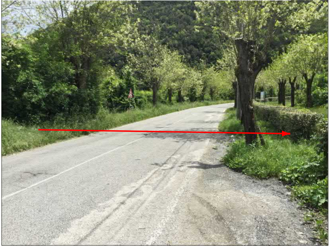
Attraversamento S.P. n.31
