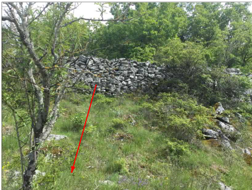
Particolare muretto a secco
