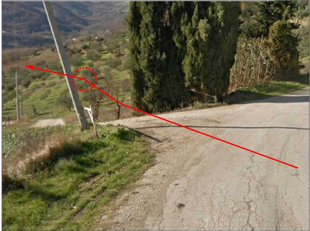
Ingresso Microtunnel "Colle della Guardia"
