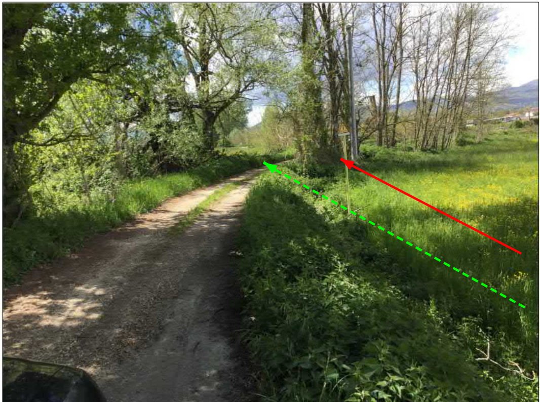
Attraversamento strada bianca e Canale
