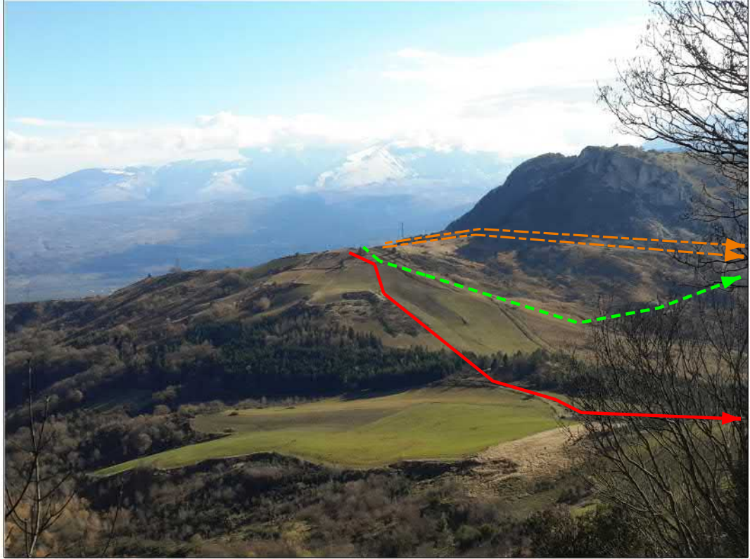
Uscita microtunnel "Roccatagliata"
