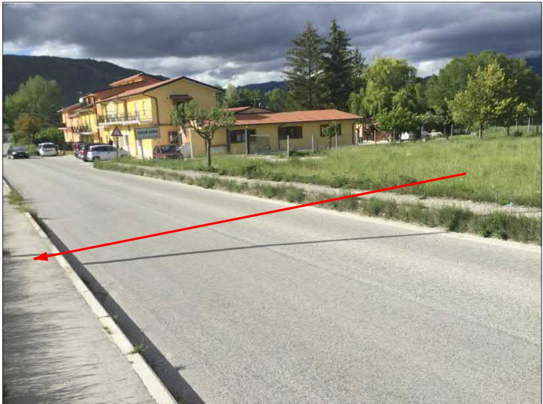
Attraversamento strada comunale
