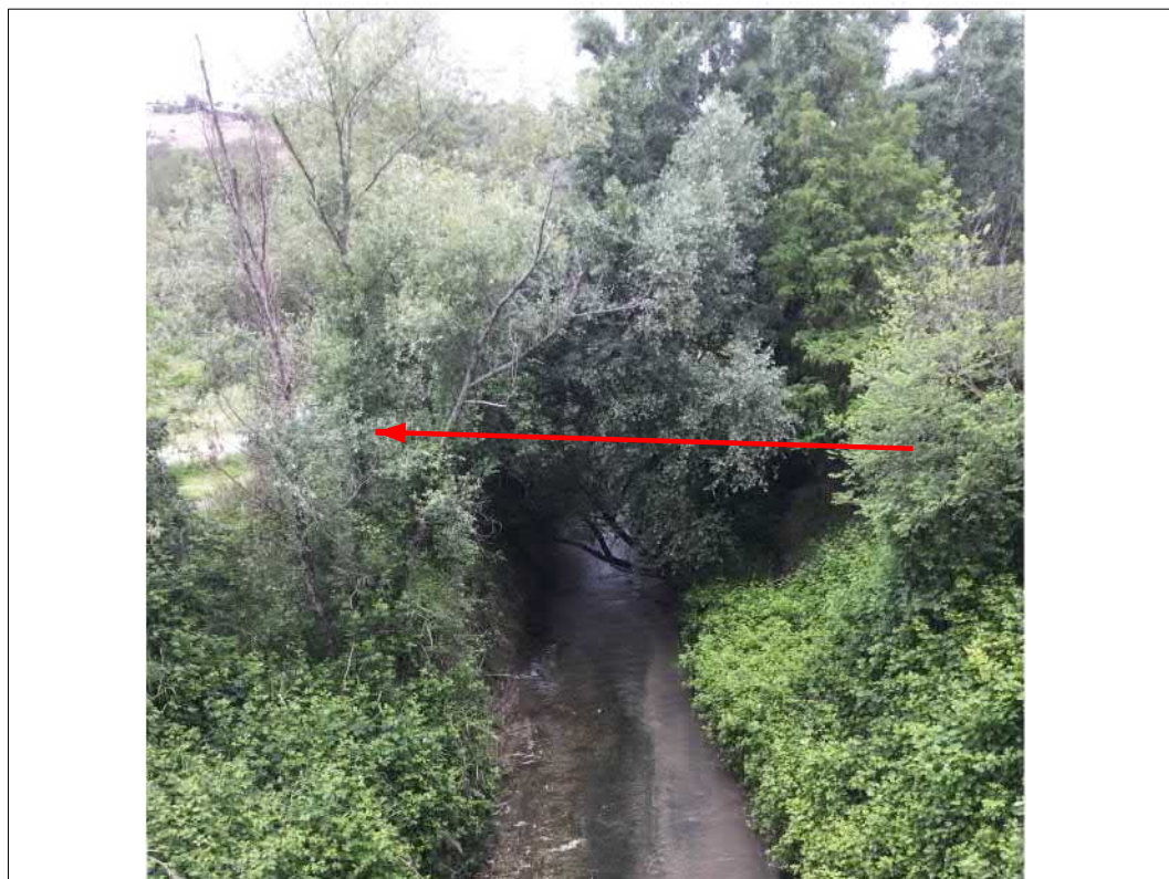
Attraversamento fosso S.M. D'Arabona
