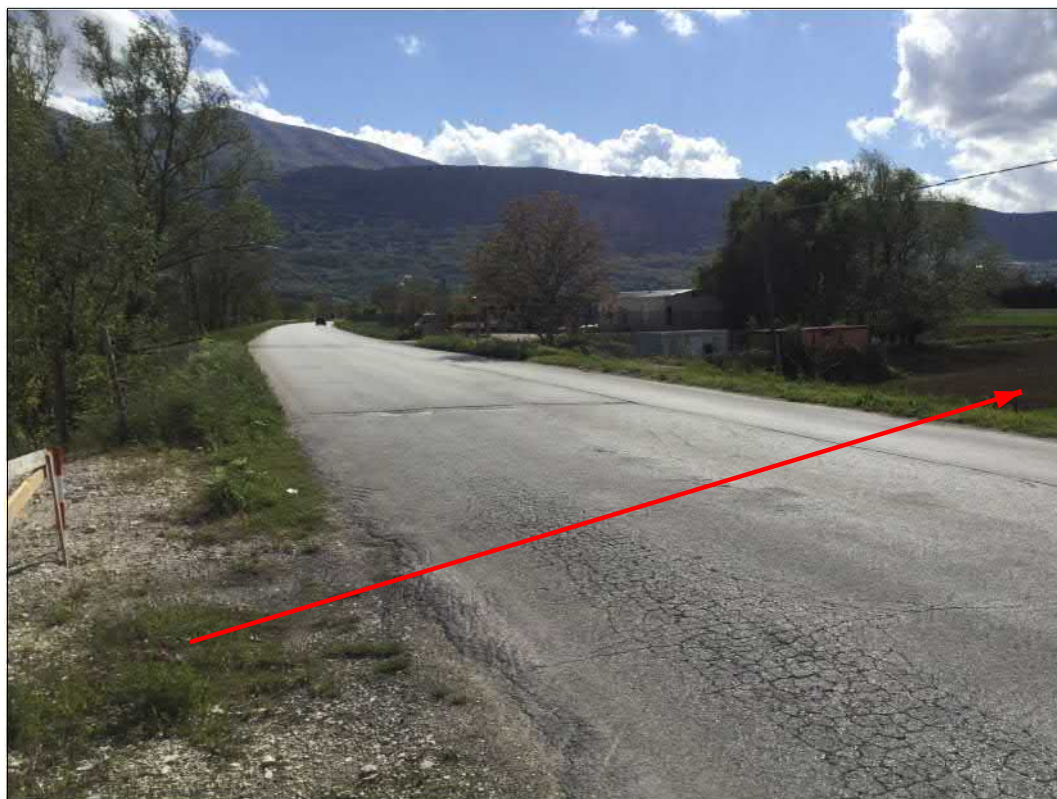
Attraversamento strada comunale
