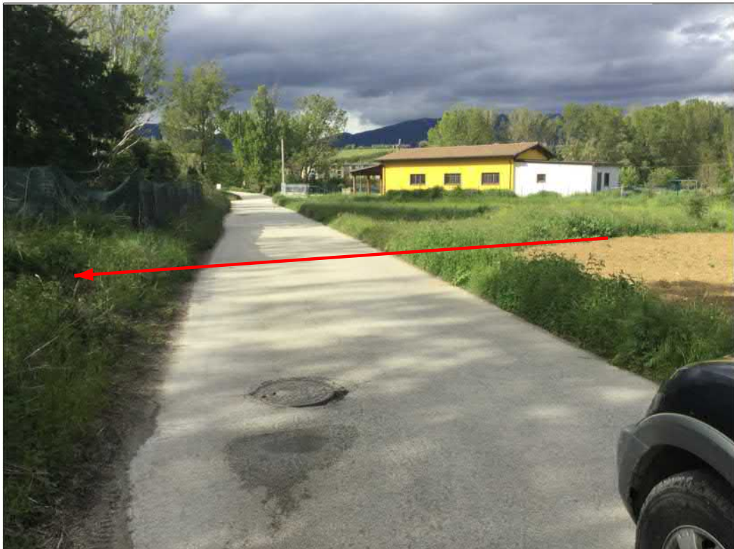
Attraversamento strada comunale
