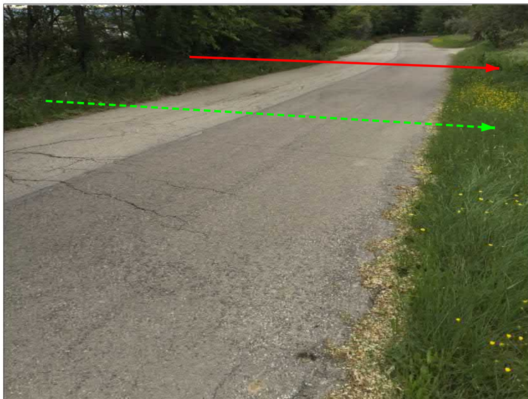
Attraversamento S.P. n.58
