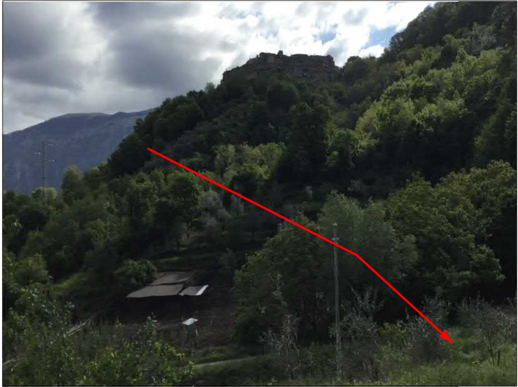
Uscita microtunnel "Borgo Velino 1"
