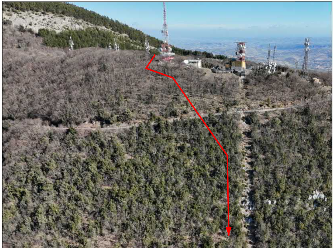
Aggiramento area antenne e inizio discesa Pietracorniale
