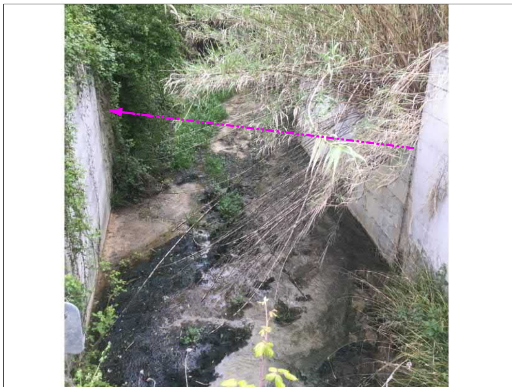
Ricollegamento variante "Interporto" – attraversamento fosso Calabrese
