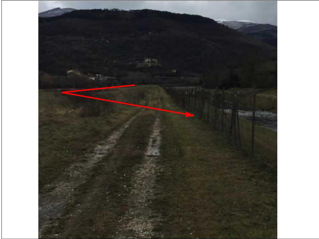
Attraversamento Canale di Scarico Societa' Terni tramite TOC
