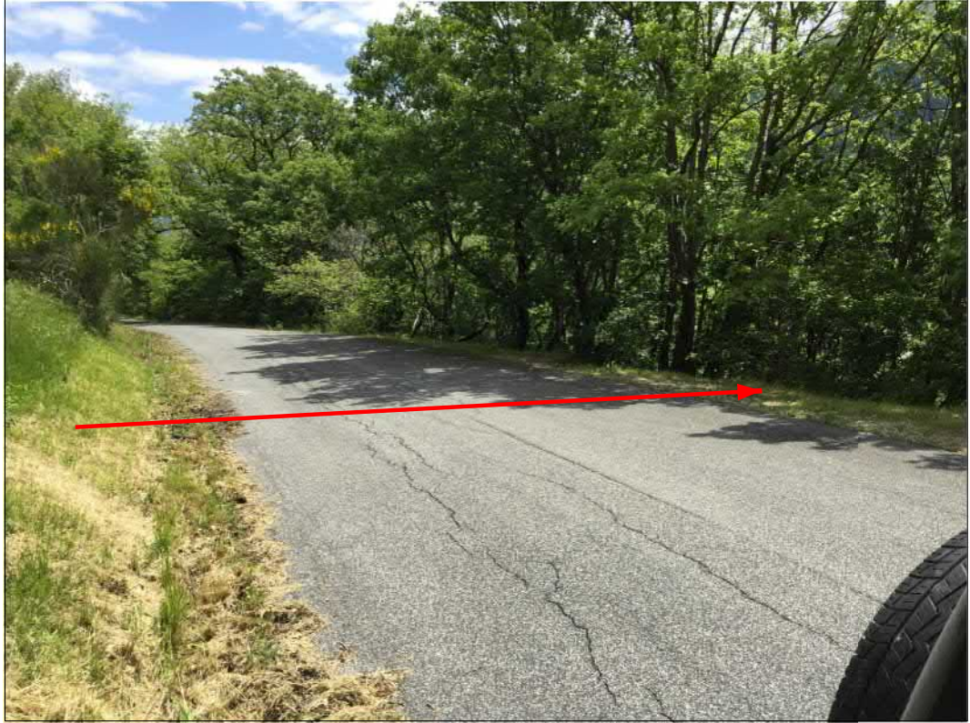
Attraversamento strada comunale
