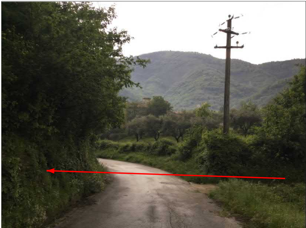
Ingresso microtunnel "Borgo Velino 1"
