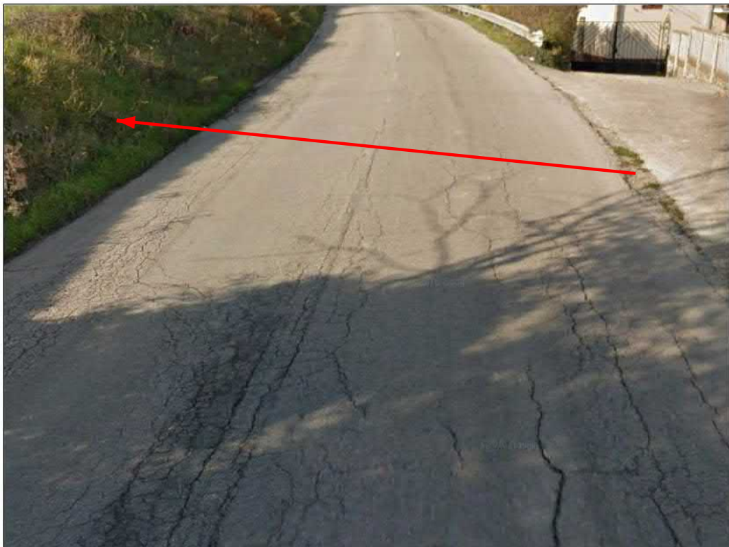
Attraversamento strada comunale
