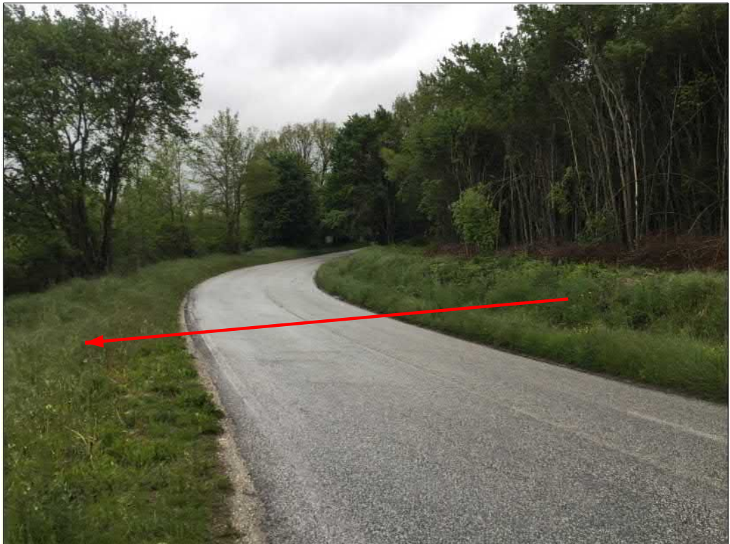
Attraversamento strada comunale
