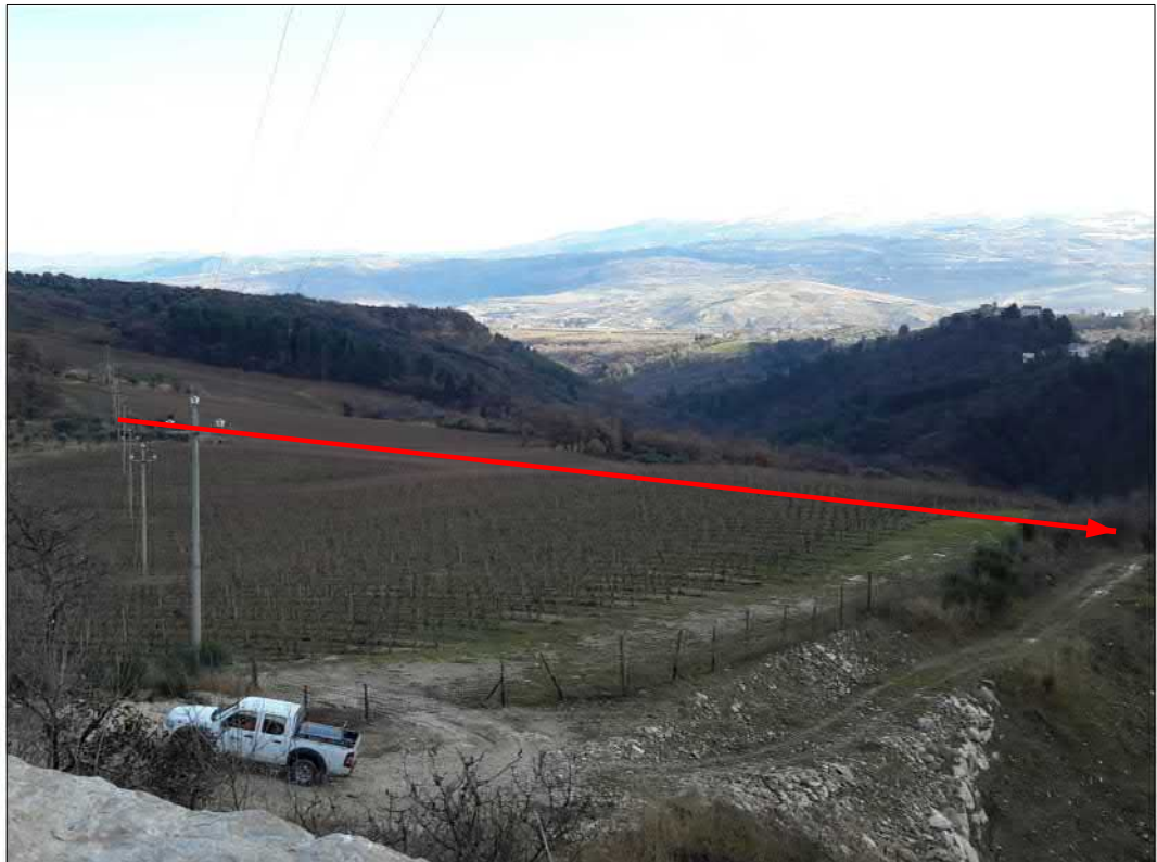
Microtunnel "Colle della Guardia"
