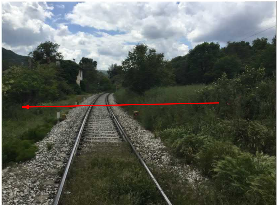
Attraversamento ferrovia Sulmona - Terni
