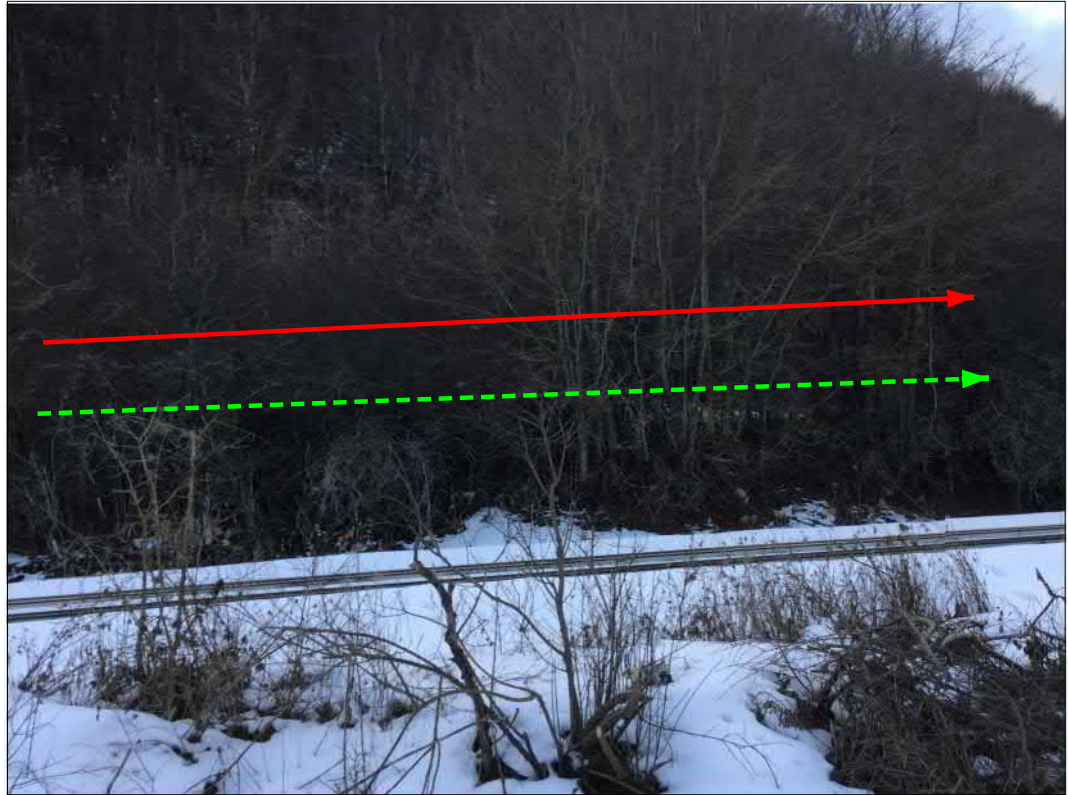
Microtunnel "Sella di Corno"
