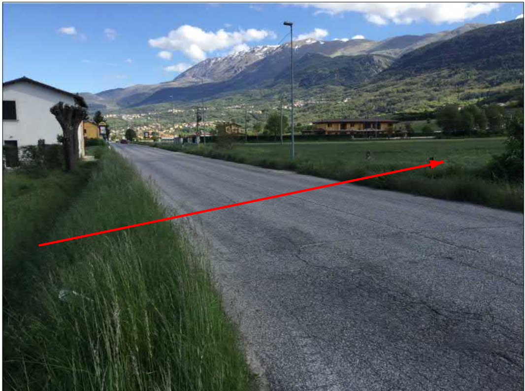
Attraversamento S.R. n.5 bis
