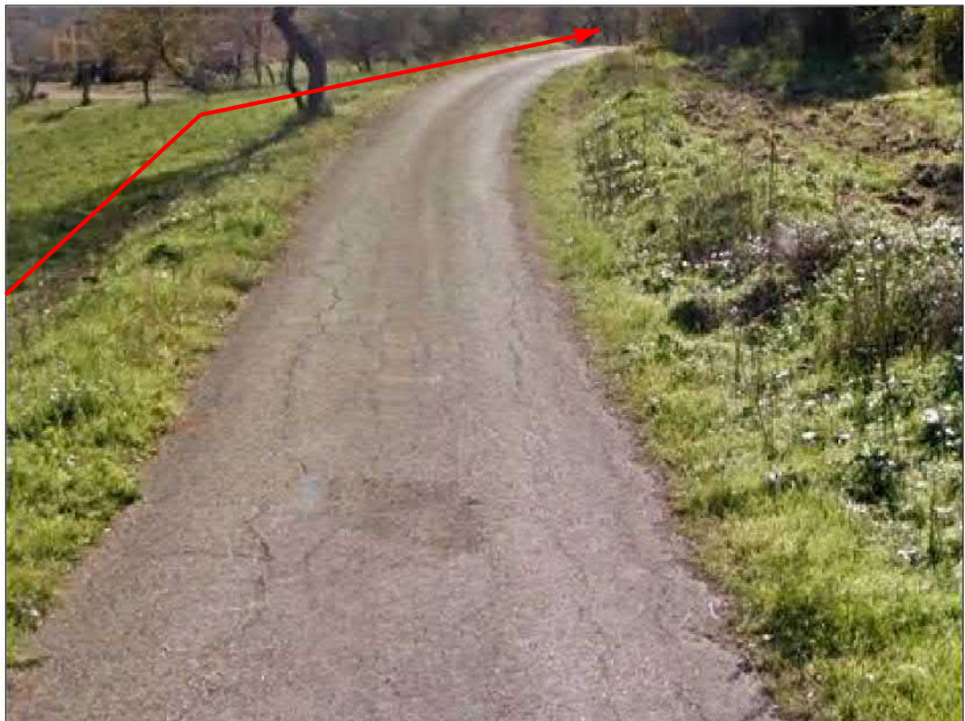
Attraversamento S.P. n.25
