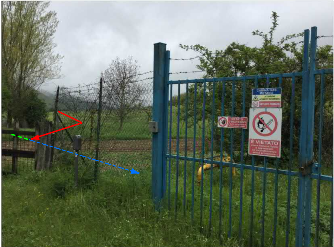
Ricollegamento metanodotto esistente
