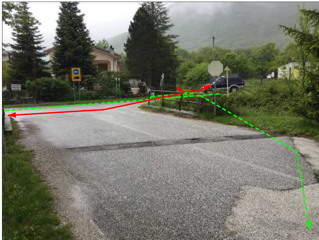
Attraversamento S.P. n.31
