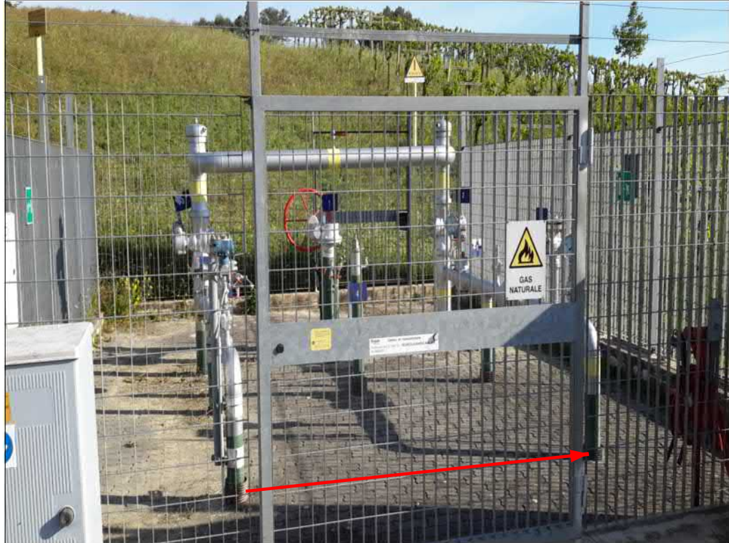
Ricollegamento metanodotto esistente
