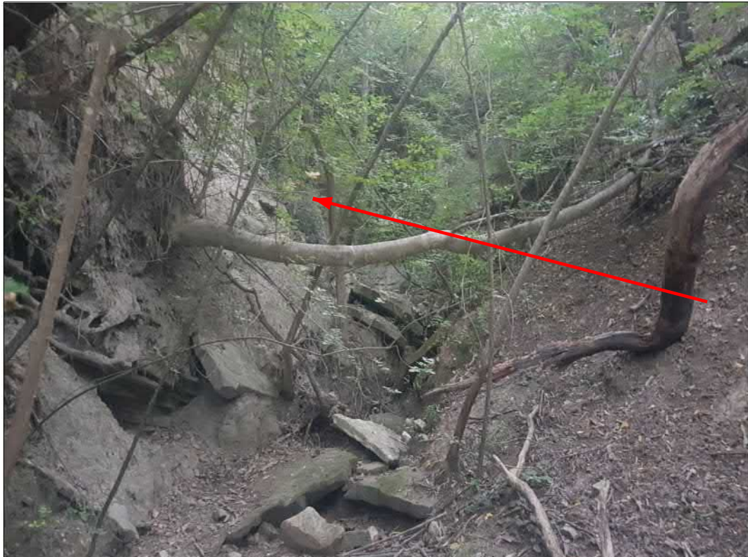
Attraversamento fosso Dei Colli
