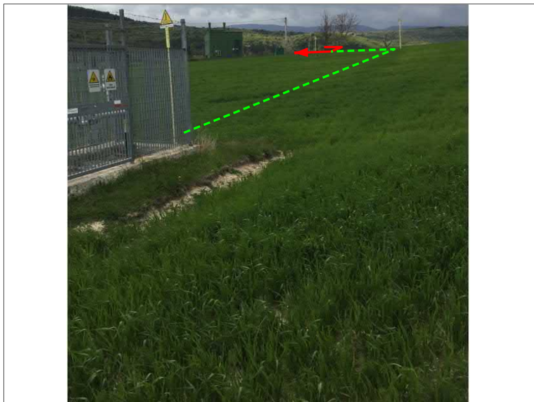
Rimozione e sostituzione allacciamento esistente
