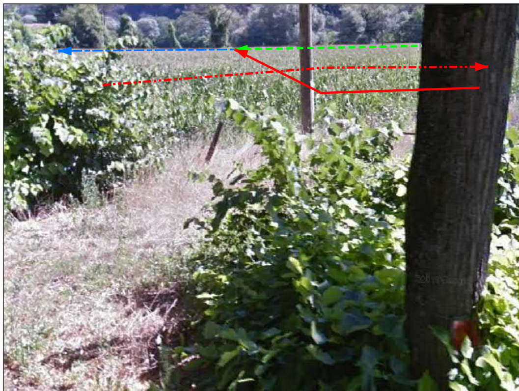
Ricollegamento metanodotto esistente
