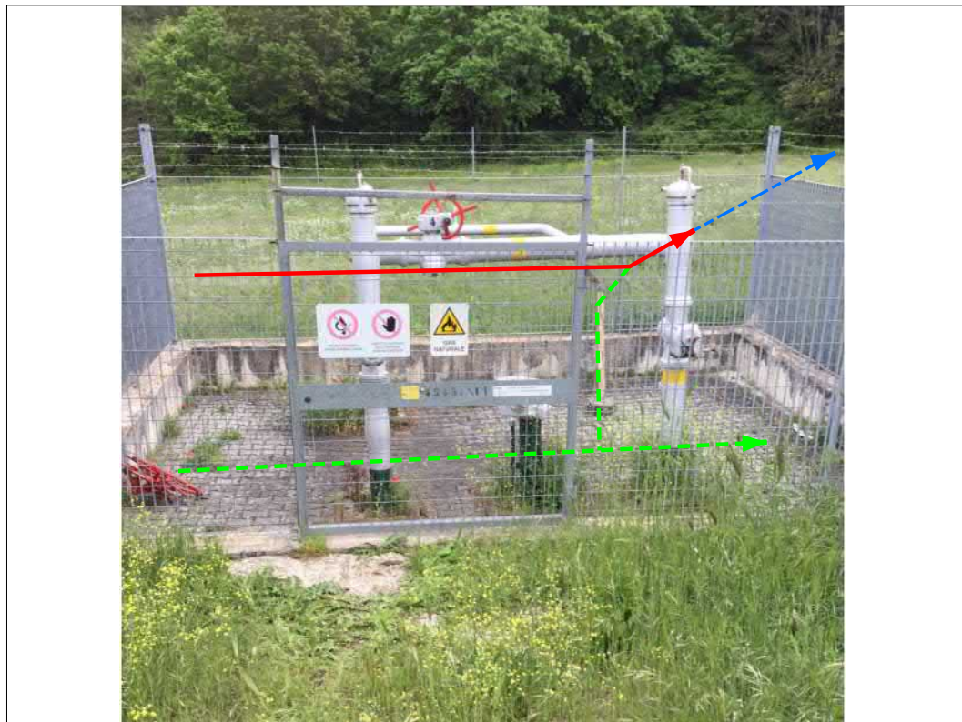
Ricollegamento metanodotto esistente
