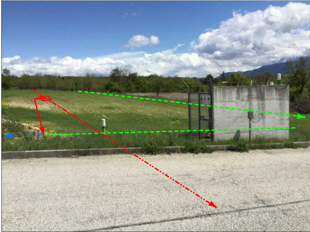
Stacco da PIDI e ricollegamento metanodotto esistente
