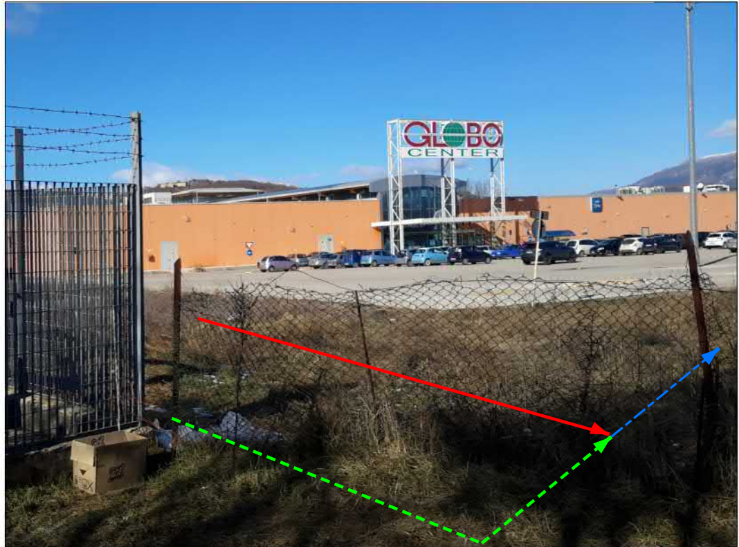
Ricollegamento metanodotto esistente
