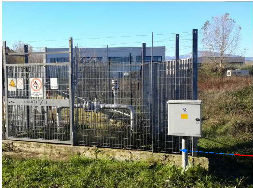
Ricollegamento metanodotto esistente
