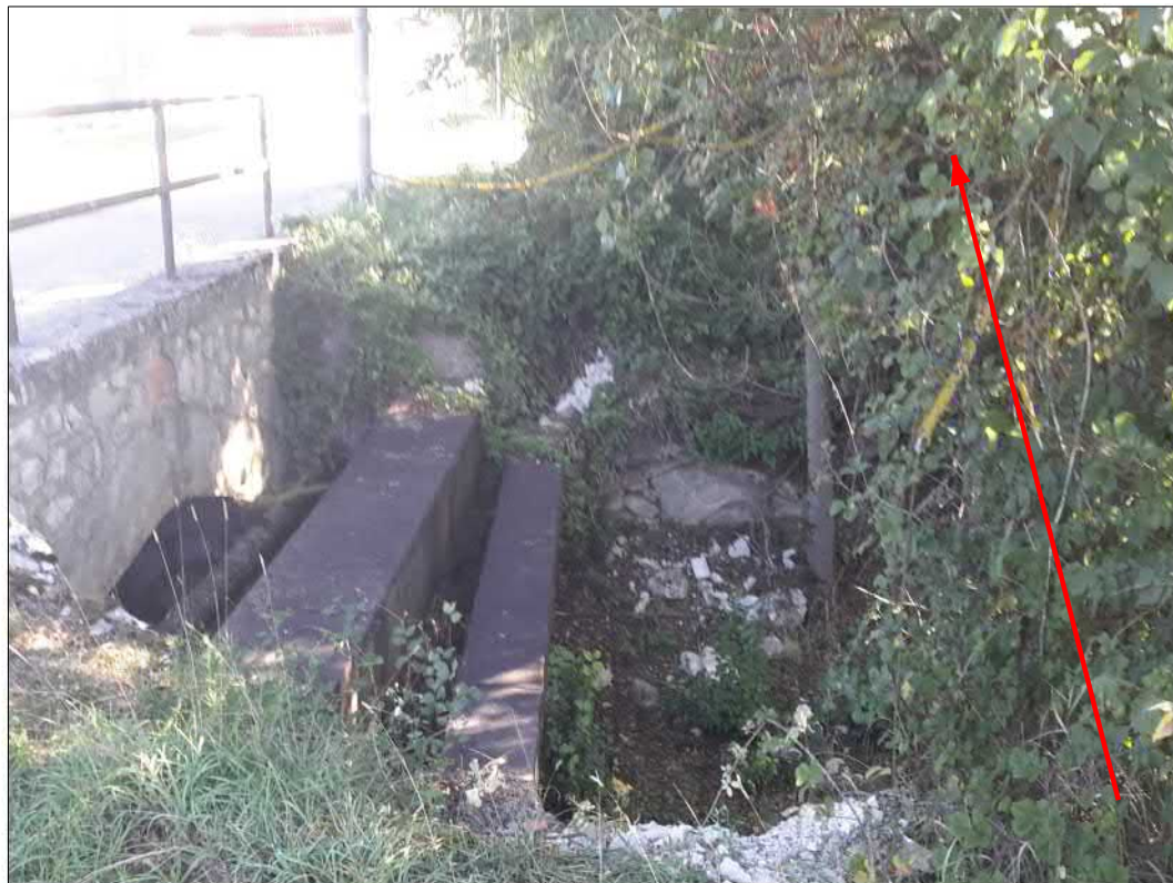
Attraversamento il Fossato
