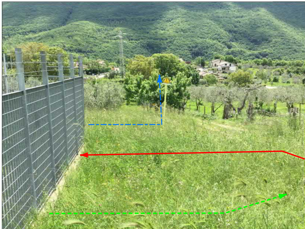
Ricollegamento metanodotto esistente
