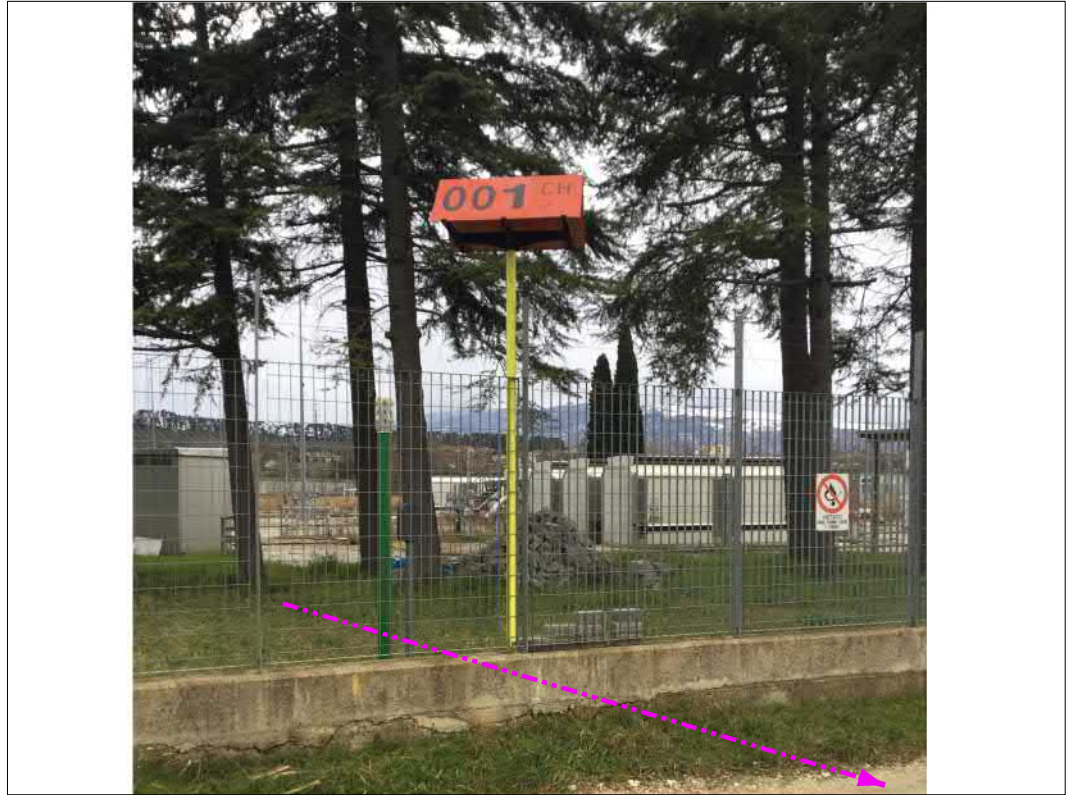
Recinzione impianto Brecciarola
