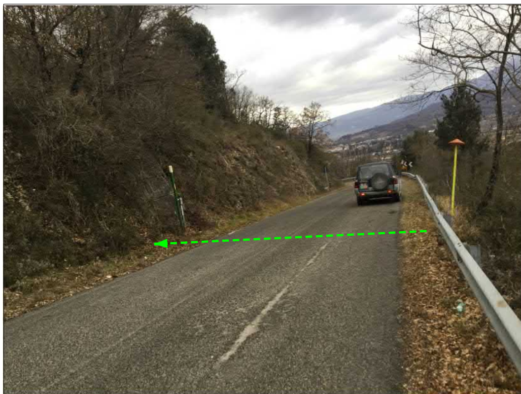
Attraversamento S.P. Sala
