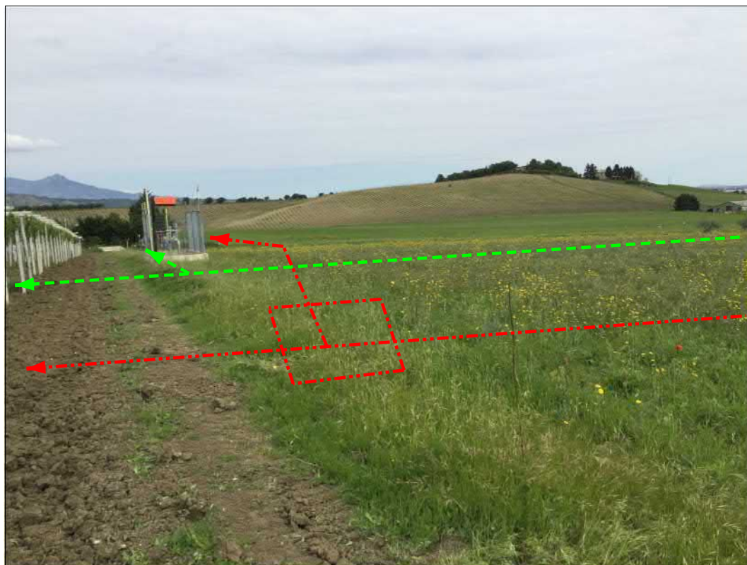
Impianto allacciamento Edison Gas
