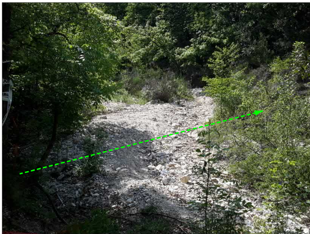
Attraversamento "Il Rivaccio"
