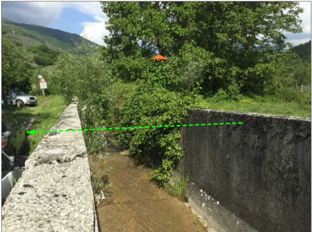
Attraversamento canale artificiale
