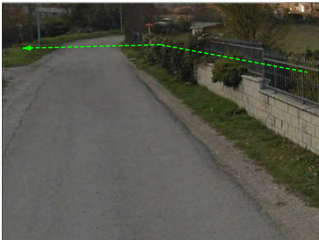
Attraversamento strada comunale
