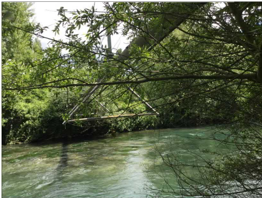
Attraversamento aereo fiume Velino
