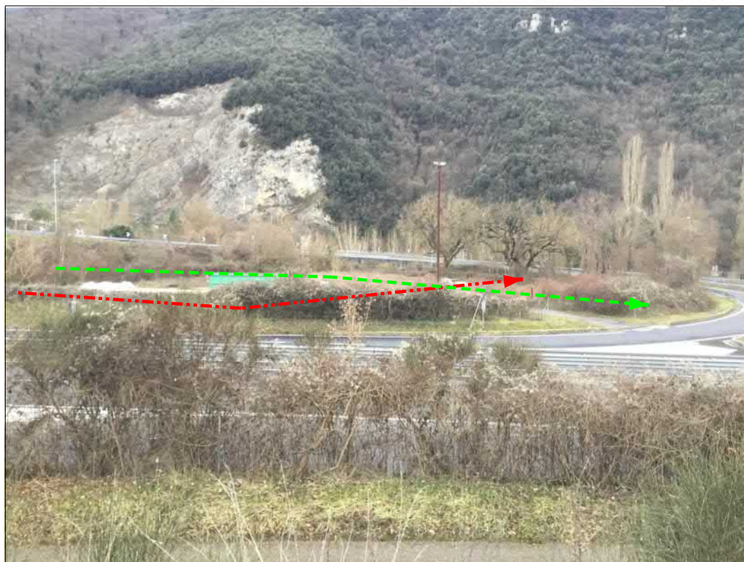
Attraversamento svincolo S.S. n.4
