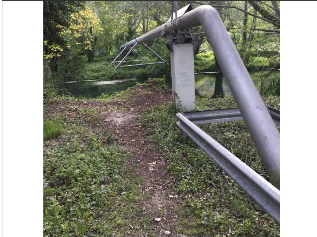
Attraversamento fiume Tirino
