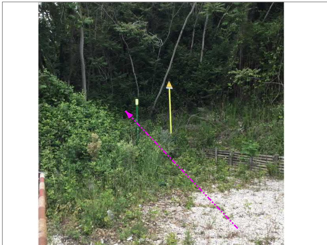
Ricollegamento variante "Cigno"_microtunnel
