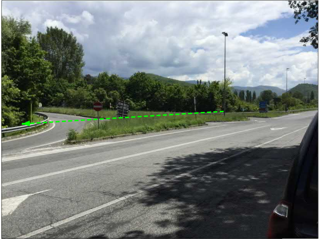
Attraversamento svincolo S.S. n.578
