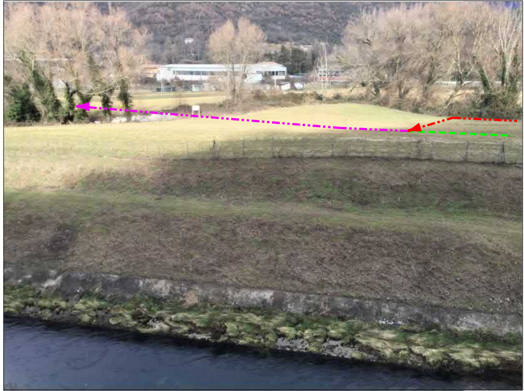
Ricollegamento attraversamento fiume Velino
