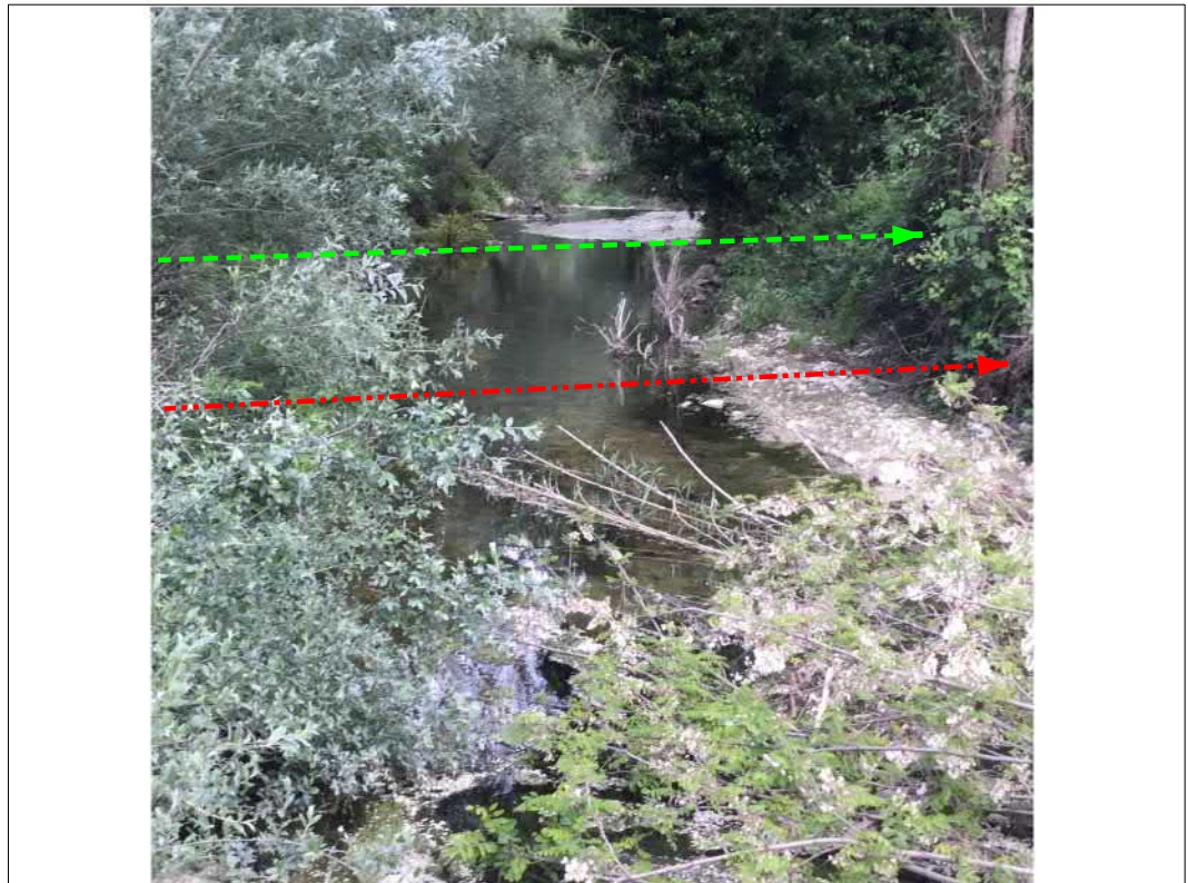
Attraversamento torrente Cigno
