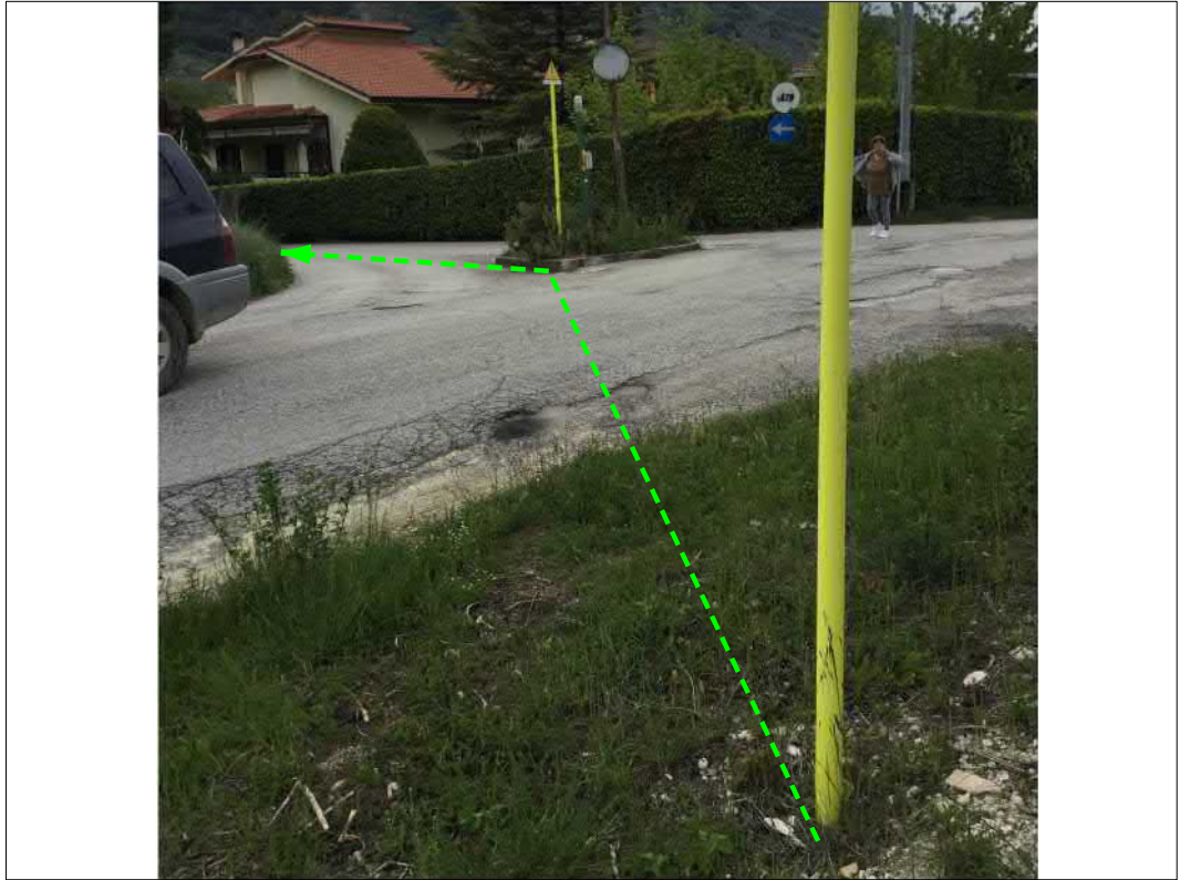
Attraversamento strada comunale
