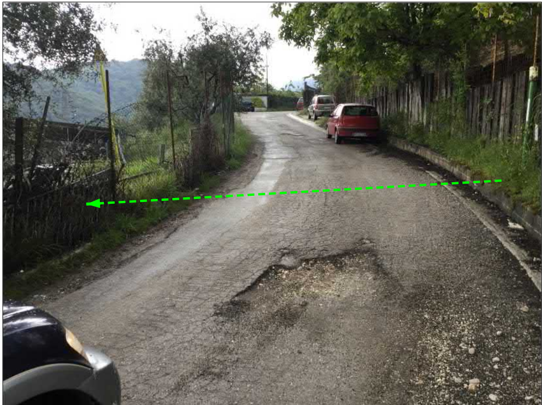
Attraversamento strada comunale
