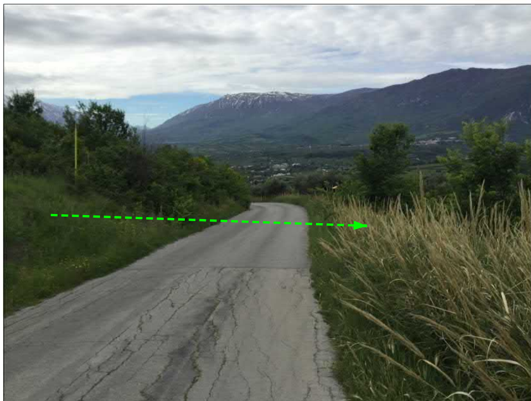
Attraversamento strada comunale
