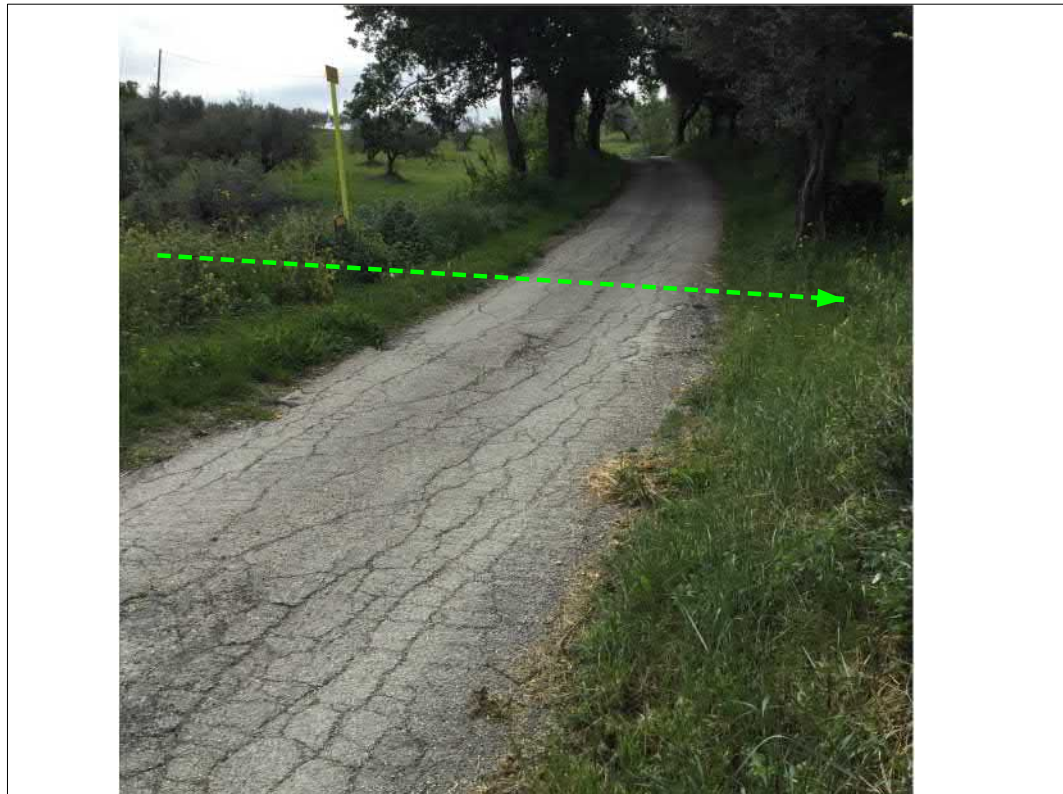
Attraversamento strada comunale
