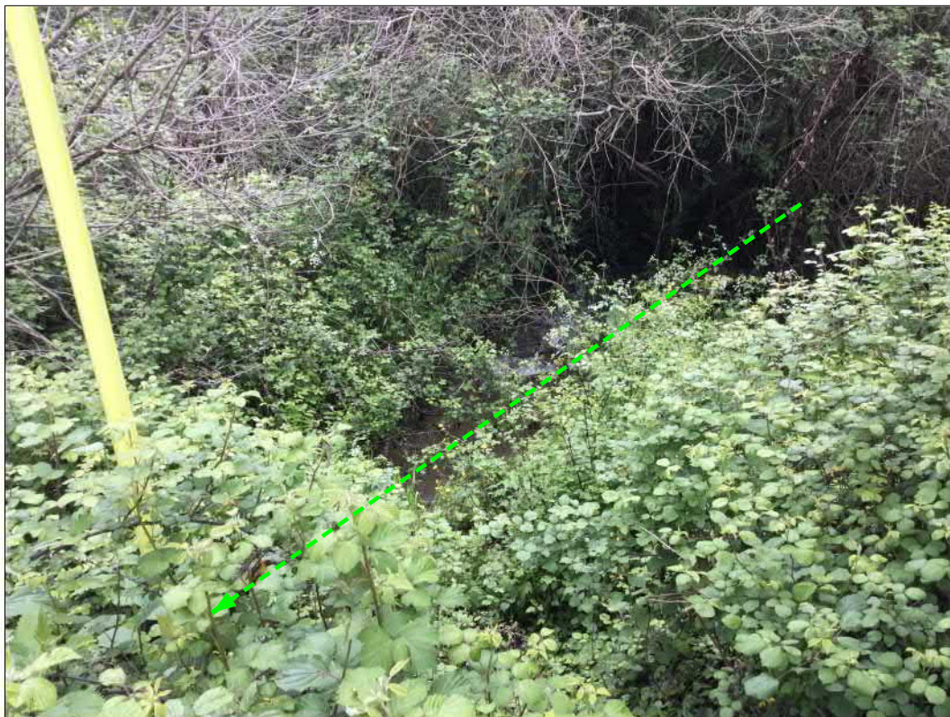
Attraversamento fosso dei Peschi
