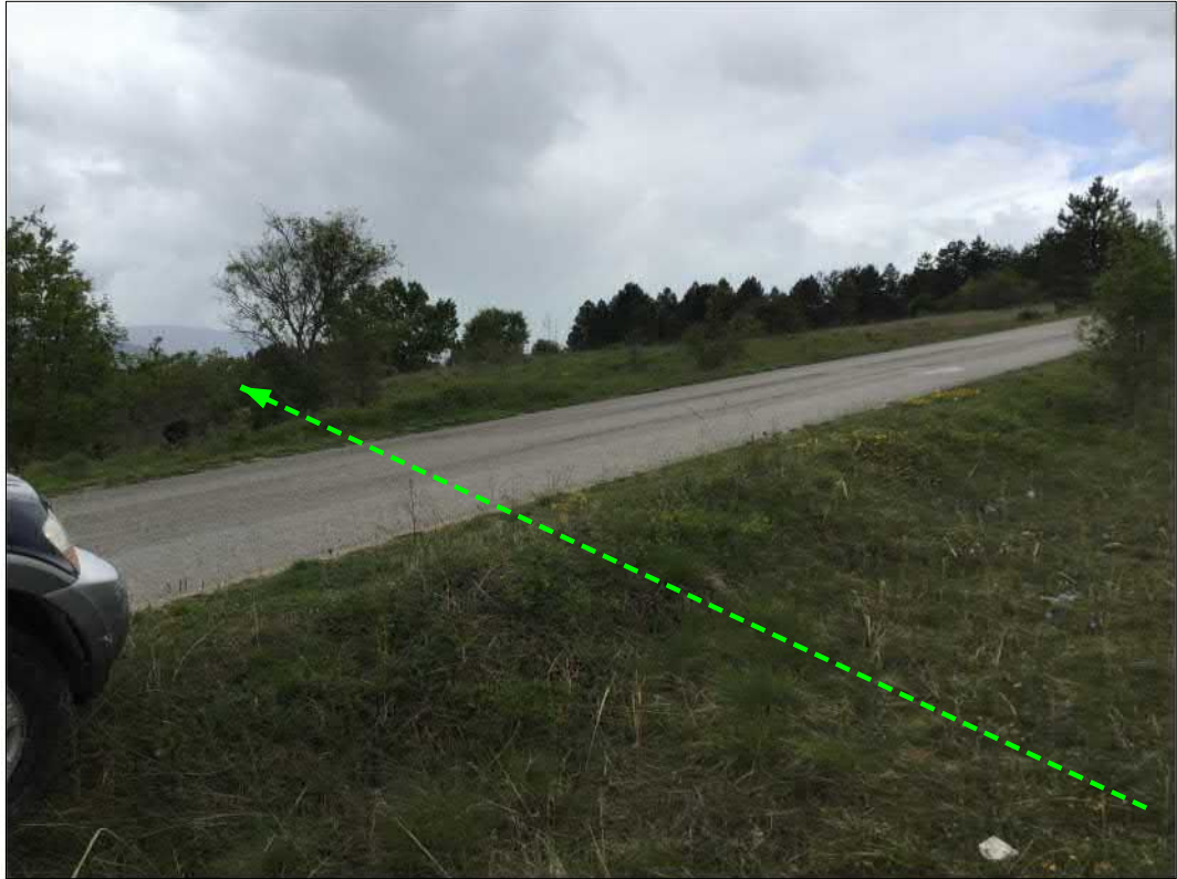
Attraversamento Strada Comunale
