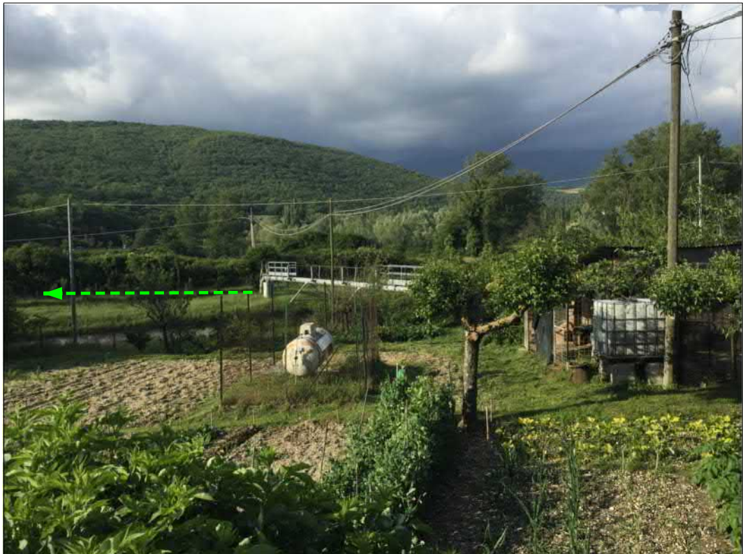
Attraversamento Canale di Scarico Societa' Terni
