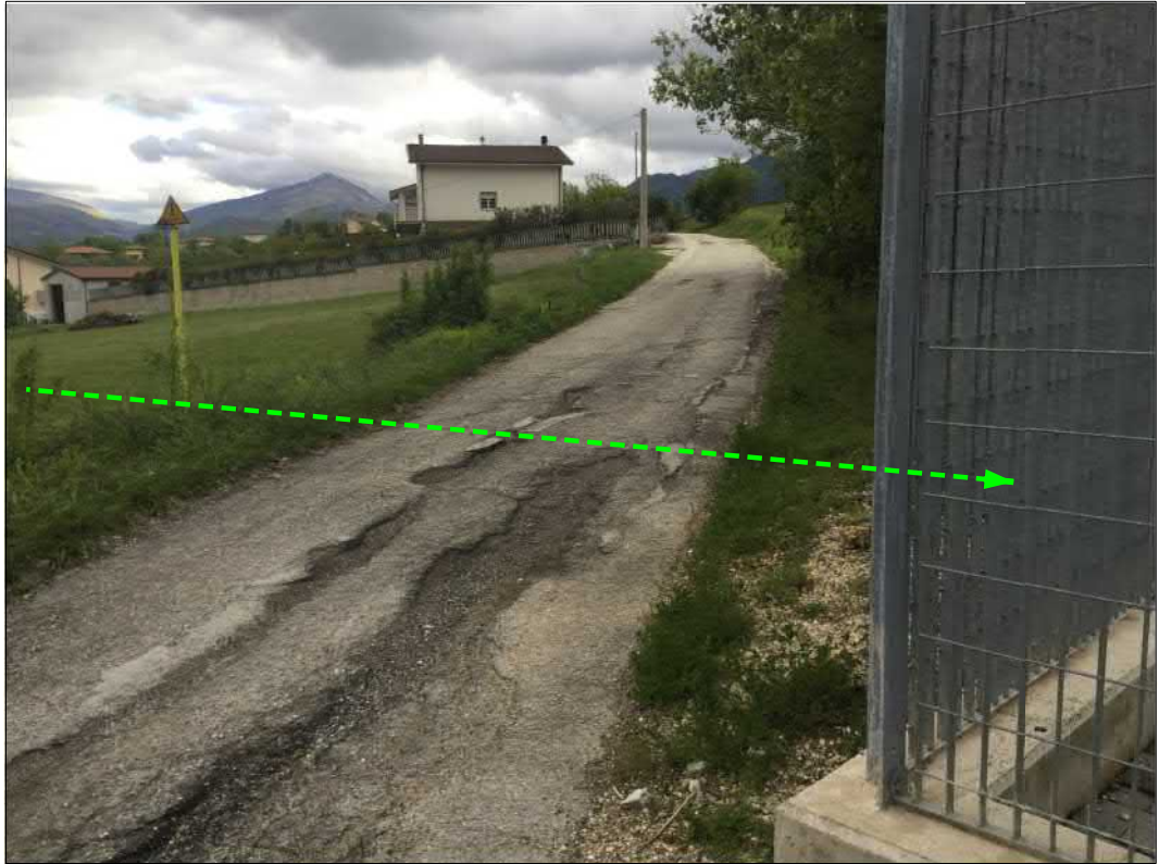
Attraversamento strada comunale
