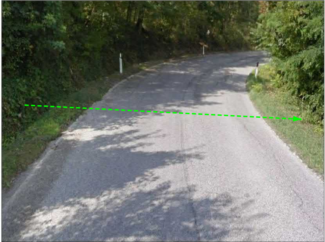
Attraversamento S.R. n.615
