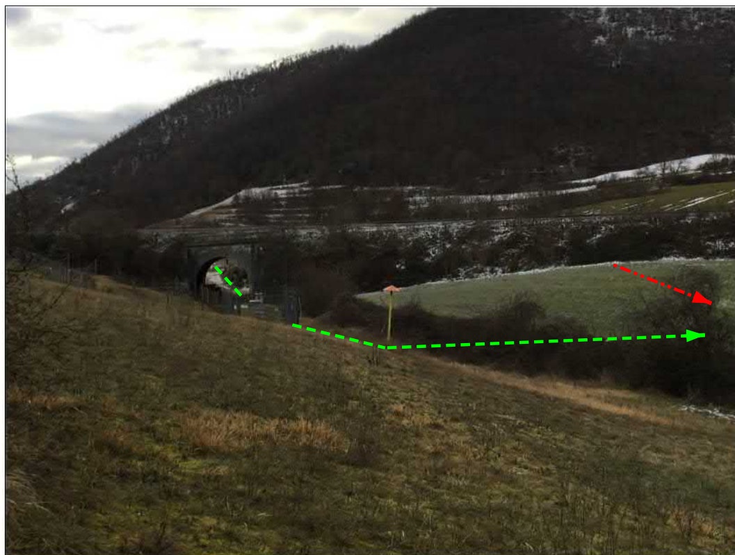
Attraversamento ferrovia e PIL 45430/22
