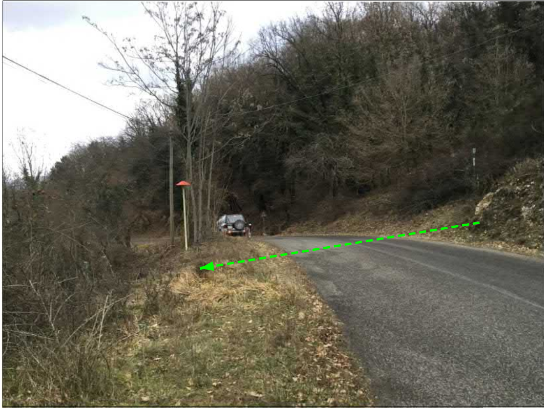
Attraversamento S.P. Sala
