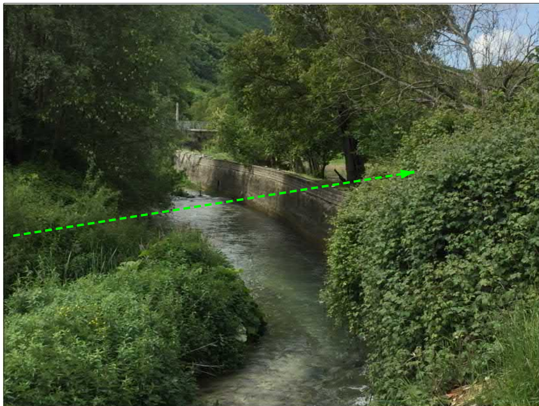
Attraversamento fiume Velino
