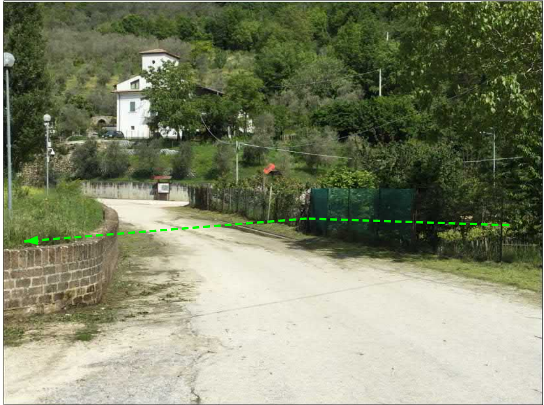
Attraversamento strada comunale
