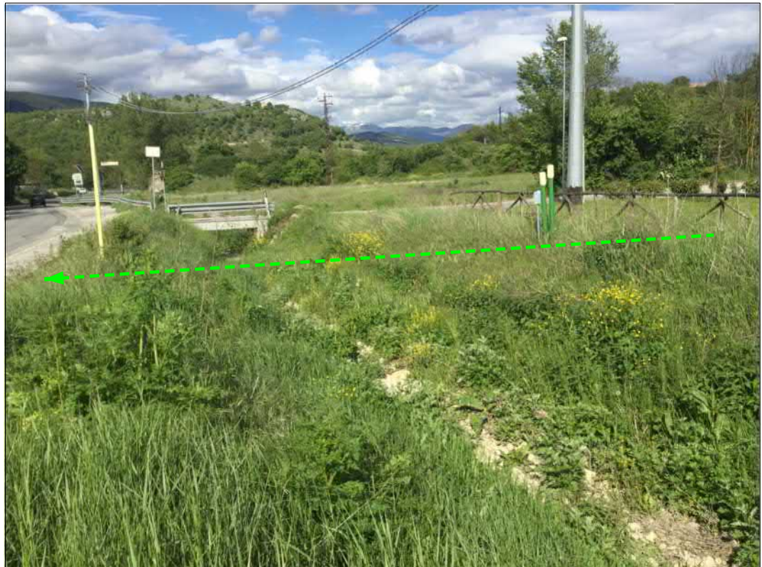
Attraversamento fosso di Genzano
