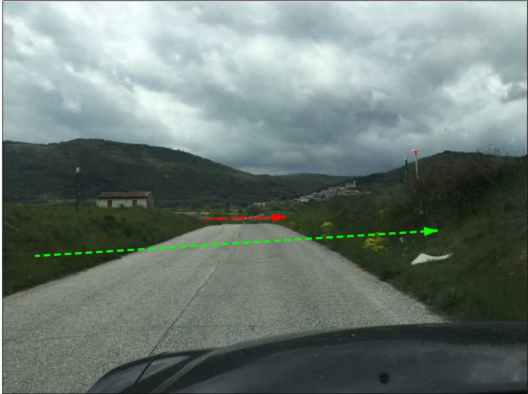
Attraversamento S.P. n.8
