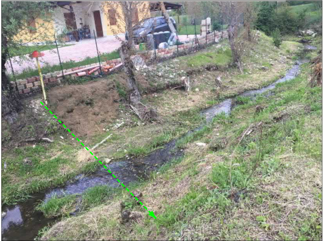
Attraversamento fosso Impredadora
