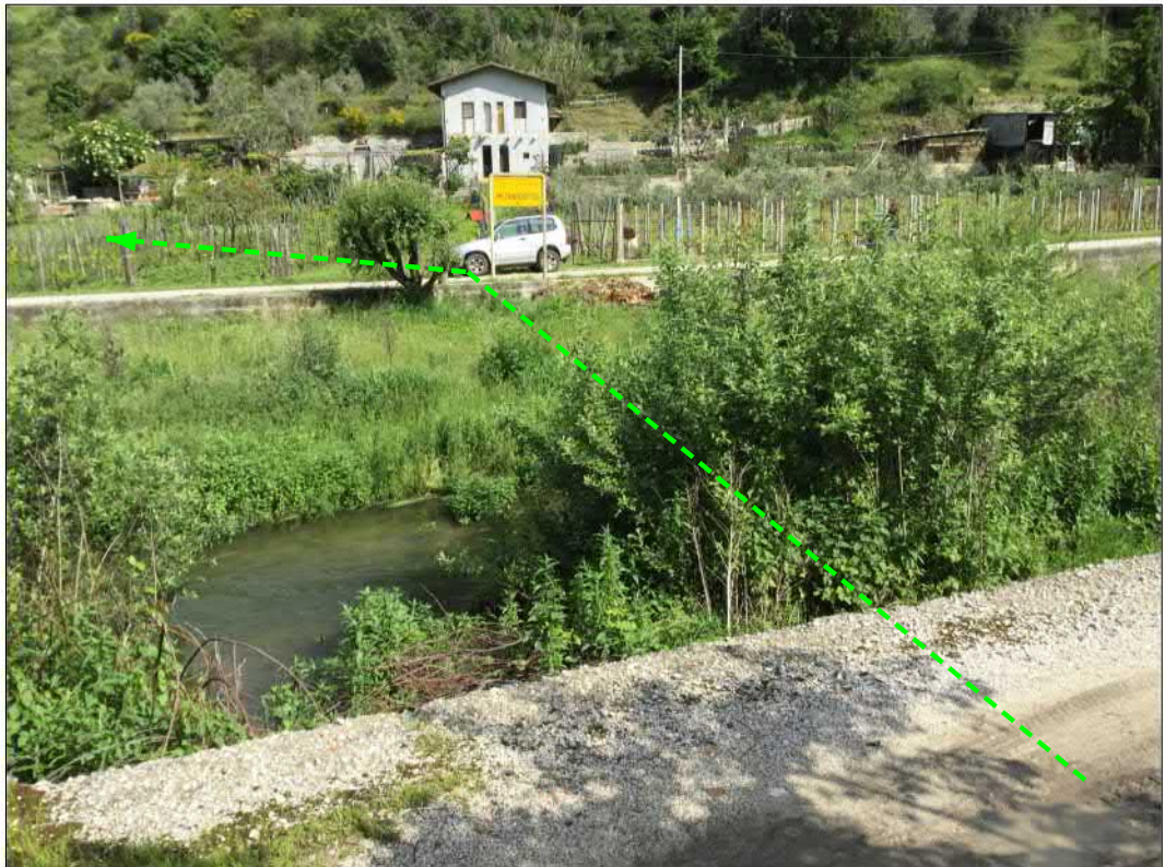
Attraversamento fiume Velino
