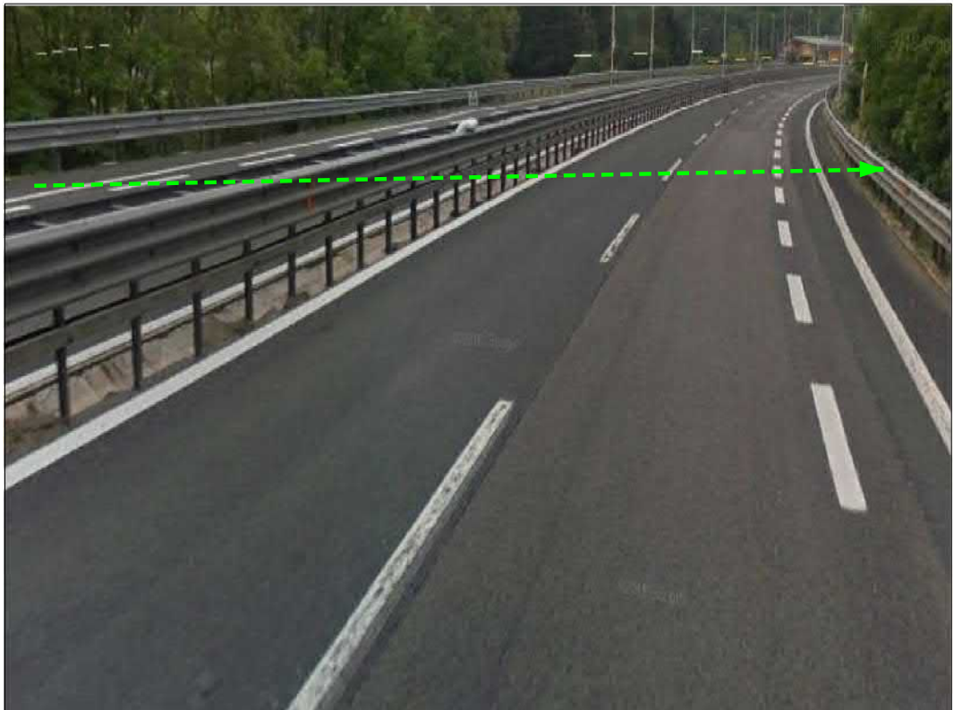
Attraversamento Autostrada A24
