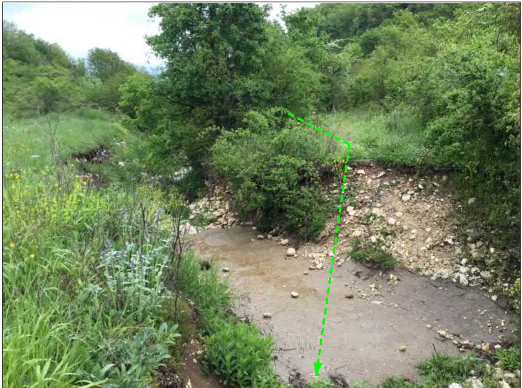
Attraversamento fosso Impredadora
