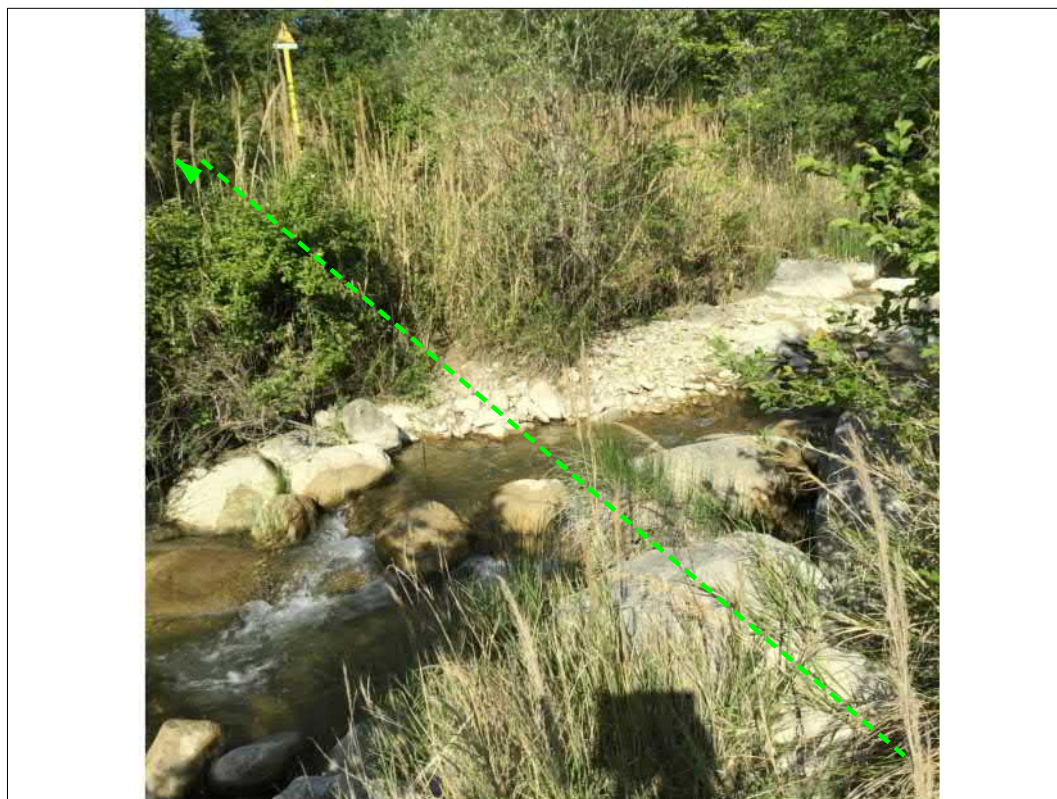
Attraversamento Fosso della Rota
