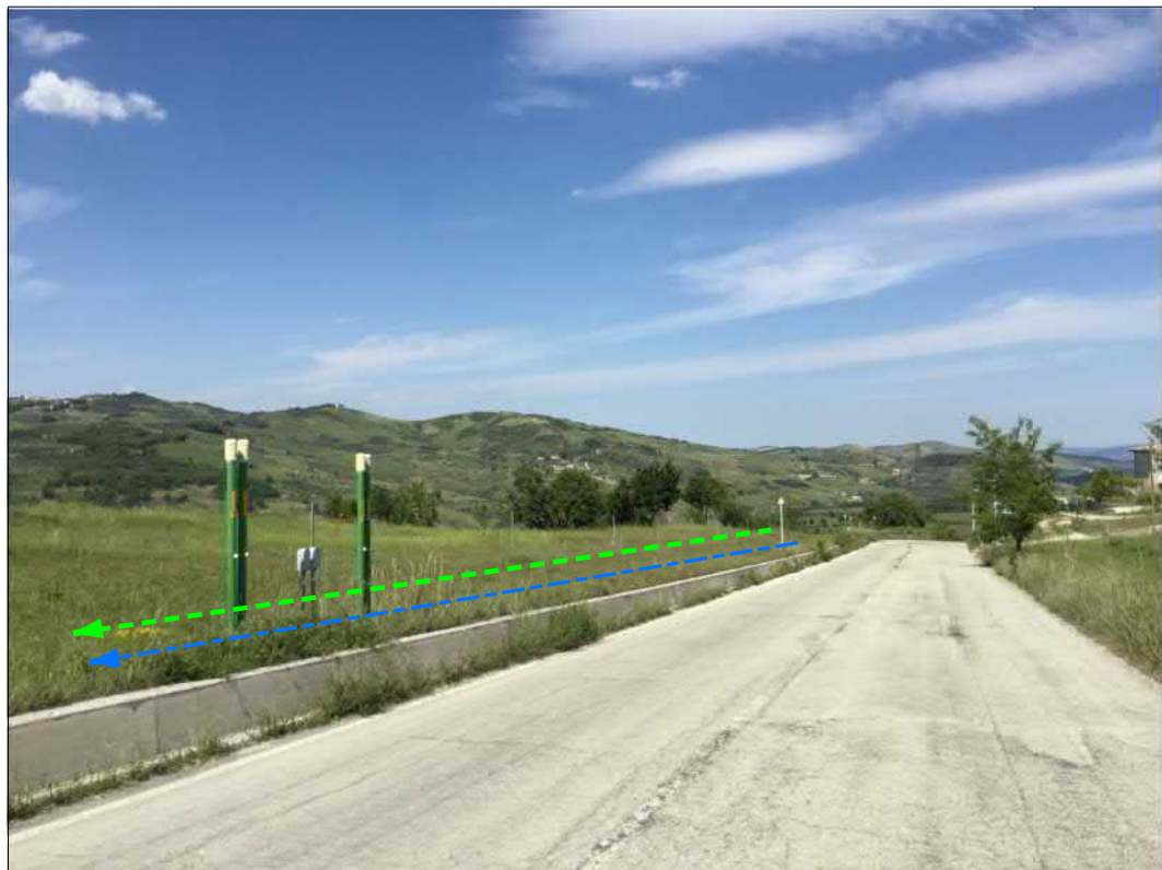
Percorrenza strada comunale in cunicolo
