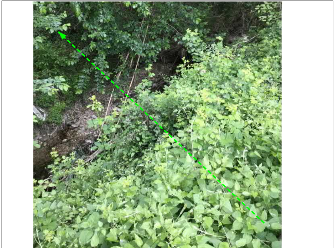
Attraversamento "Il Fossatello"
