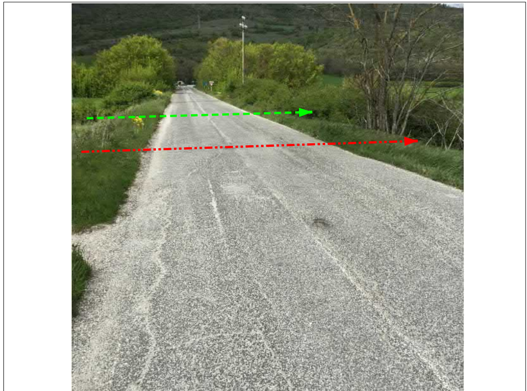
Attraversamento strada comunale
