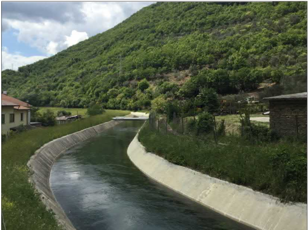
Attraversamento aereo Canale di Scolo
