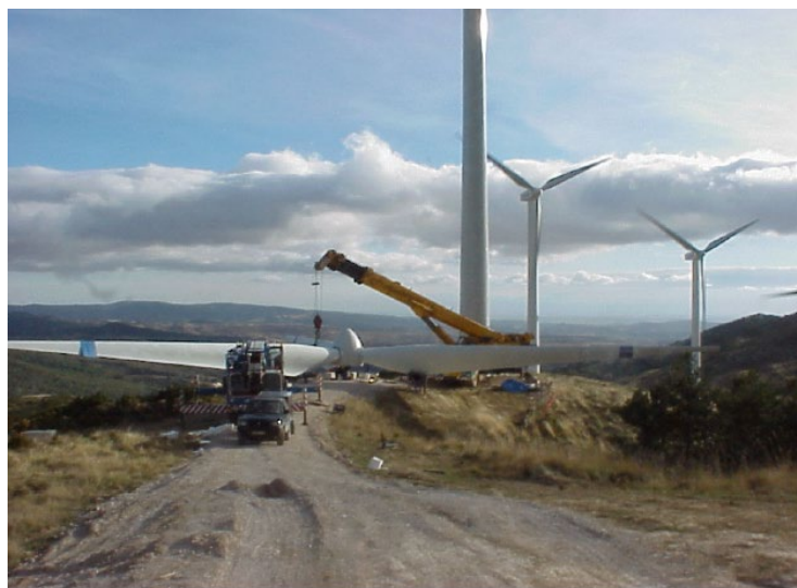
Figura 5-4: Ingombro del rotore a terra
