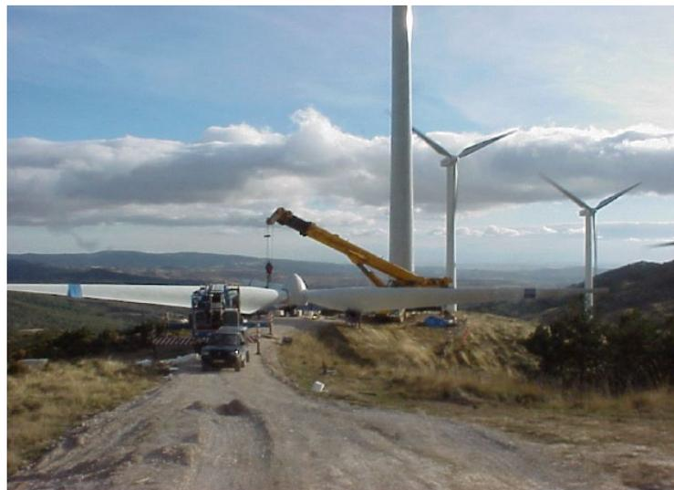
**Figura 2-4: Ingombro del rotore a terra**
