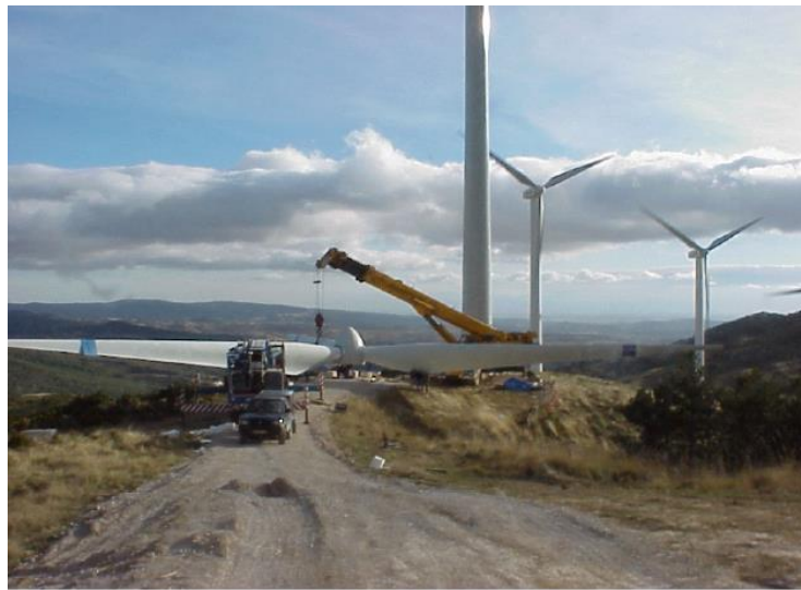
Figura 4-4: Ingombro del rotore a terra
