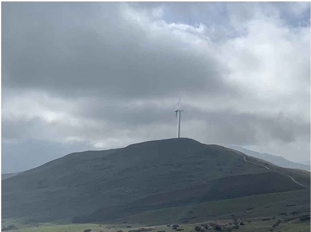
Punto di ripresa n.14 - Stato futuro
