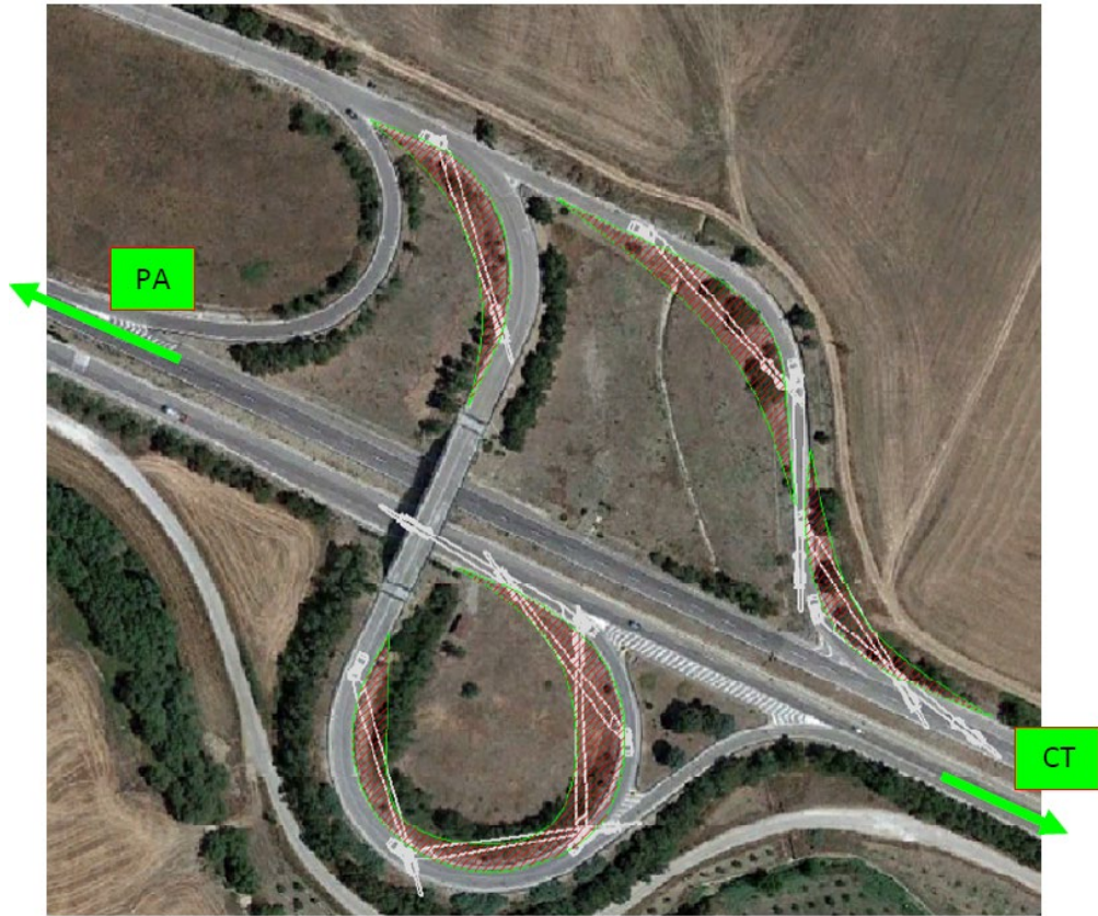
Figura 5-26: Ingombri sullo svincolo autostradale
