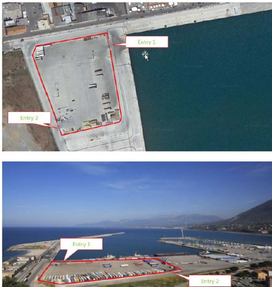
Figura 4-2: Area stoccaggio nei pressi del porto
