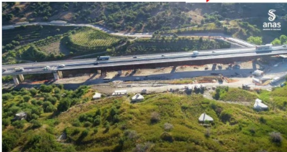
Figura 4-24: Situazione del viadotto "Imera", vista in pianta ed aerea
