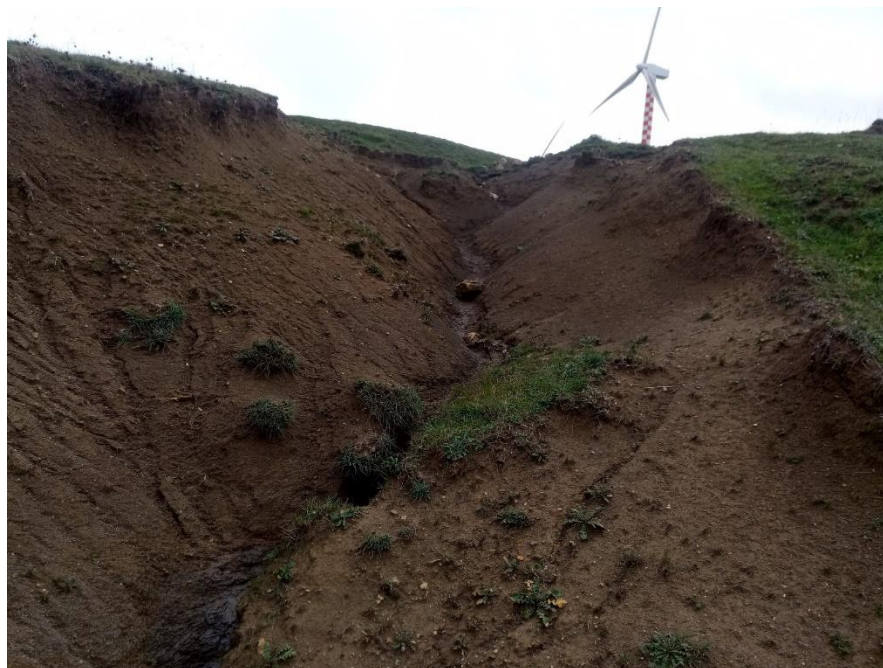
Figura 3-3: Visione del versante e fenomeni di erosione accelerata a causa di ruscellamento concentrato, facilitata dalla natura argillosa
