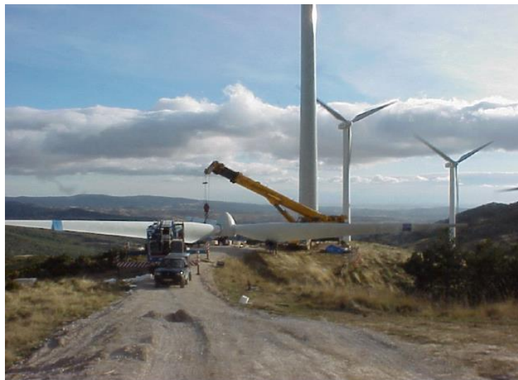
Figura 2-4: Ingombro del rotore a terra
