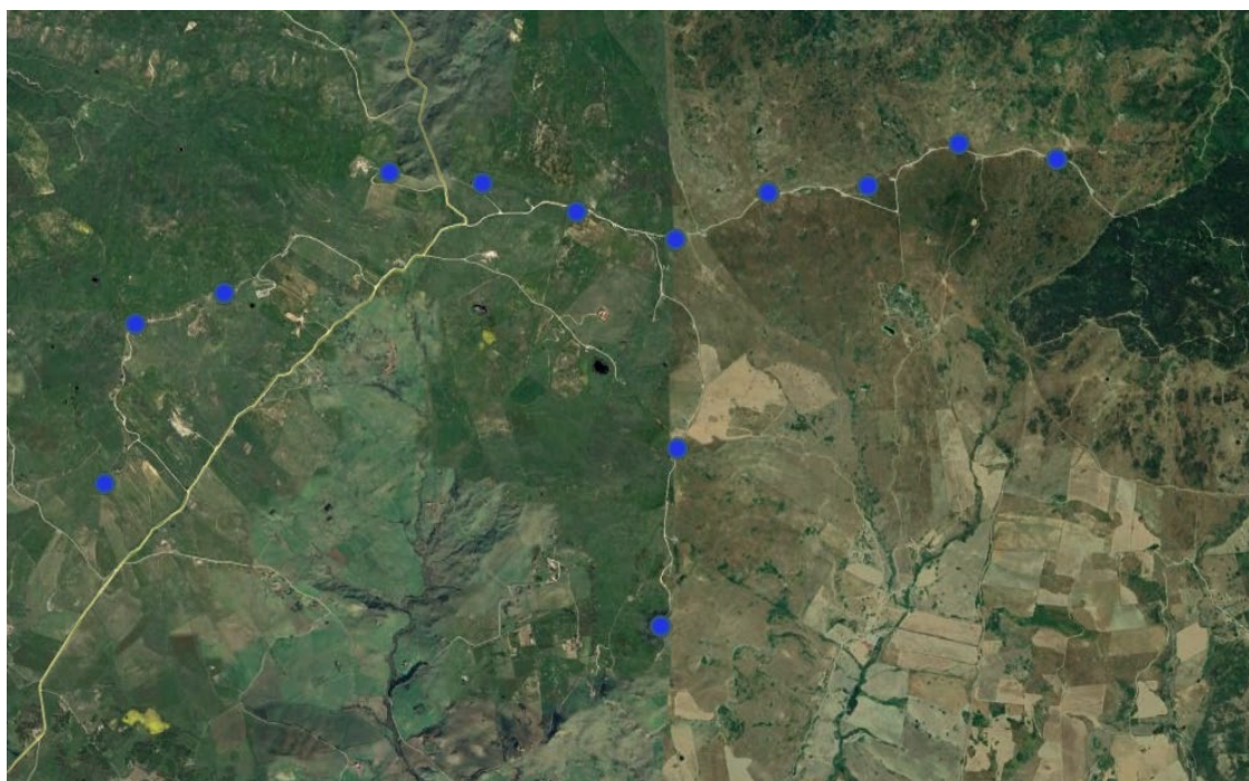
Figura 2-1: Inquadramento generale dell'area di progetto in cui sono riportate le 55 turbine eoliche attualmente presenti in sito (nella seconda immagine, in giallo) e le 13 turbine eoliche in progetto (nell'ultima immagine, in blu).
