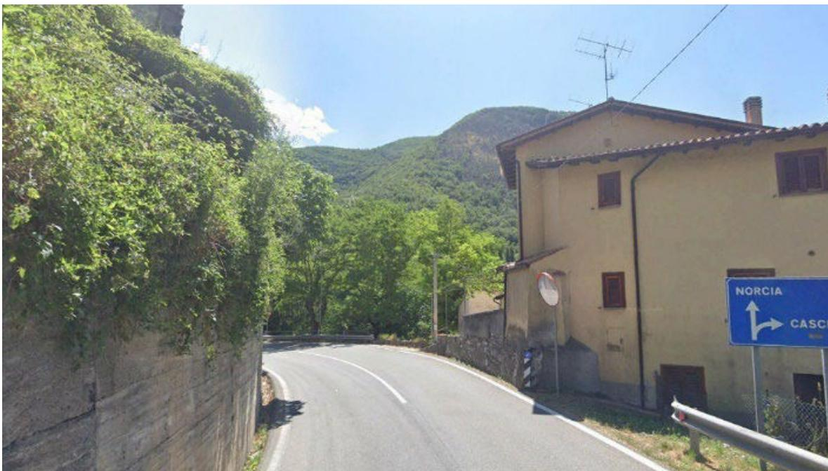
A valle dell'analisi delle criticità presenti si riscontra in particolare la necessità di riconfigurare l'intersezione di riconnessione con la S.S. 320, che presenta un incrocio a 90° con ingresso sul ponte storico medioevale che allo stato attuale, a causa delle geometrie presenti, ha reso necessario un accorgimento straordinario per requisiti di sicurezza, ovvero l'inserimento di uno stop lungo il percorso principale della Strada Statale 685.
