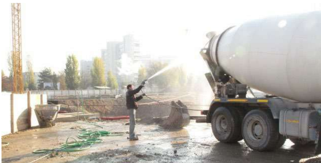
Figura 2 Esempio di lavaggio canale del mezzo di cantiere
