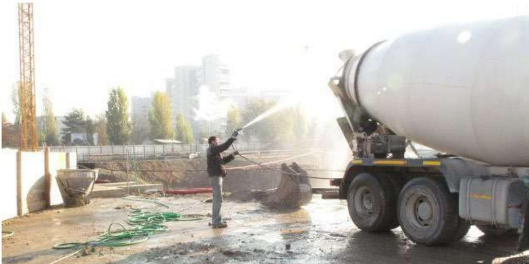
*Figura 32 Esempio di lavaggio canale del mezzo di cantiere*
