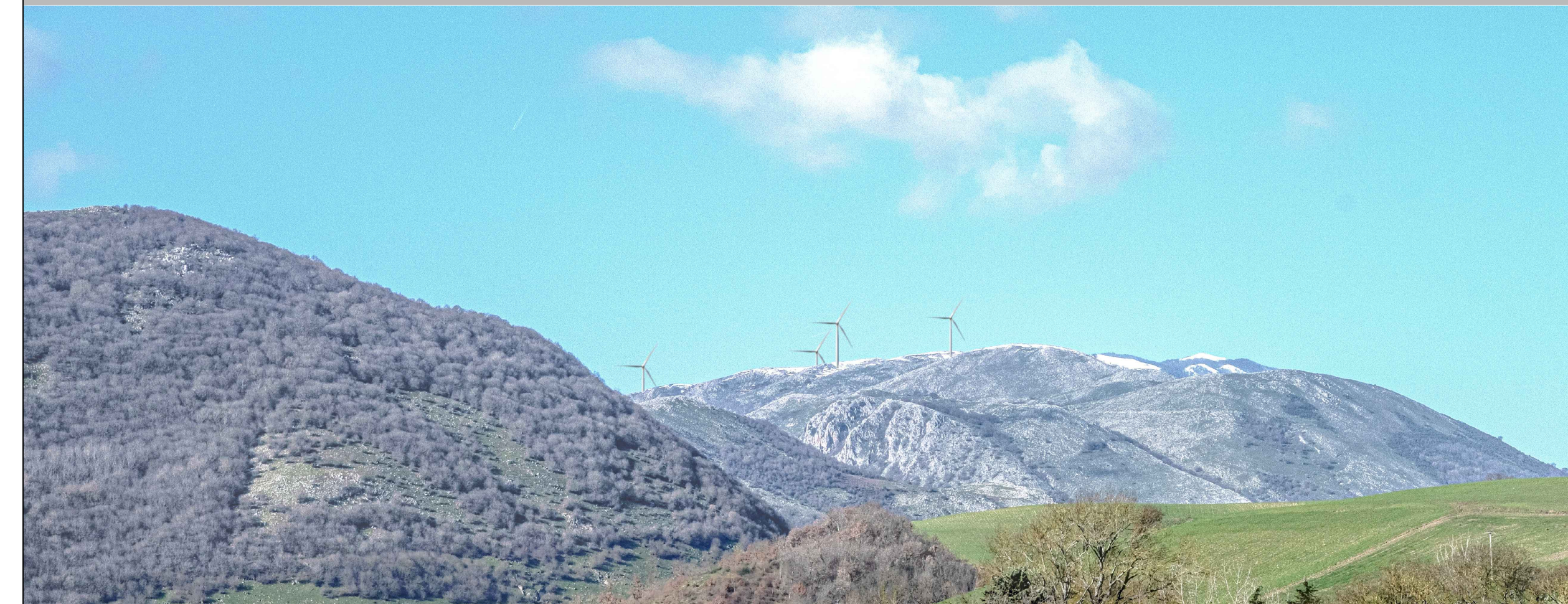
Vista del sito oggetto dell'intervento dalla stazione di Bella Muro, layout di adeguamento tecnico
