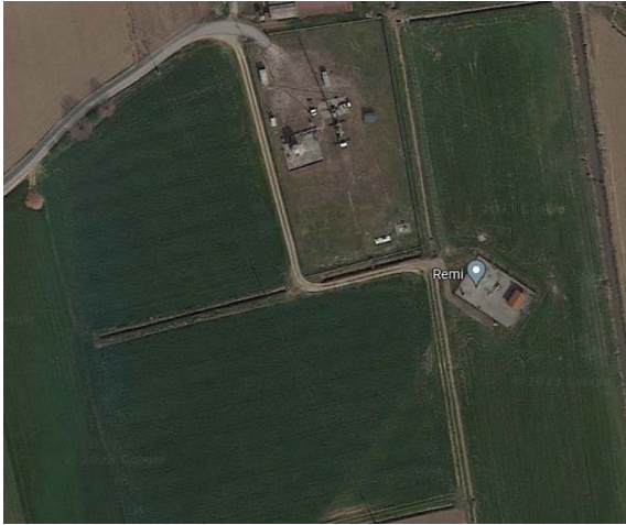
Figura 35 Strada di accesso alla cabina REMI- Stato attuale
