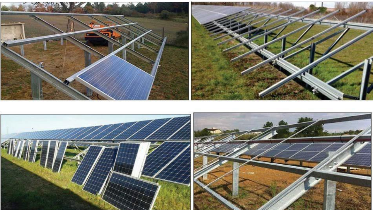
Fase 2 – Smontaggio strutture di sostegno
