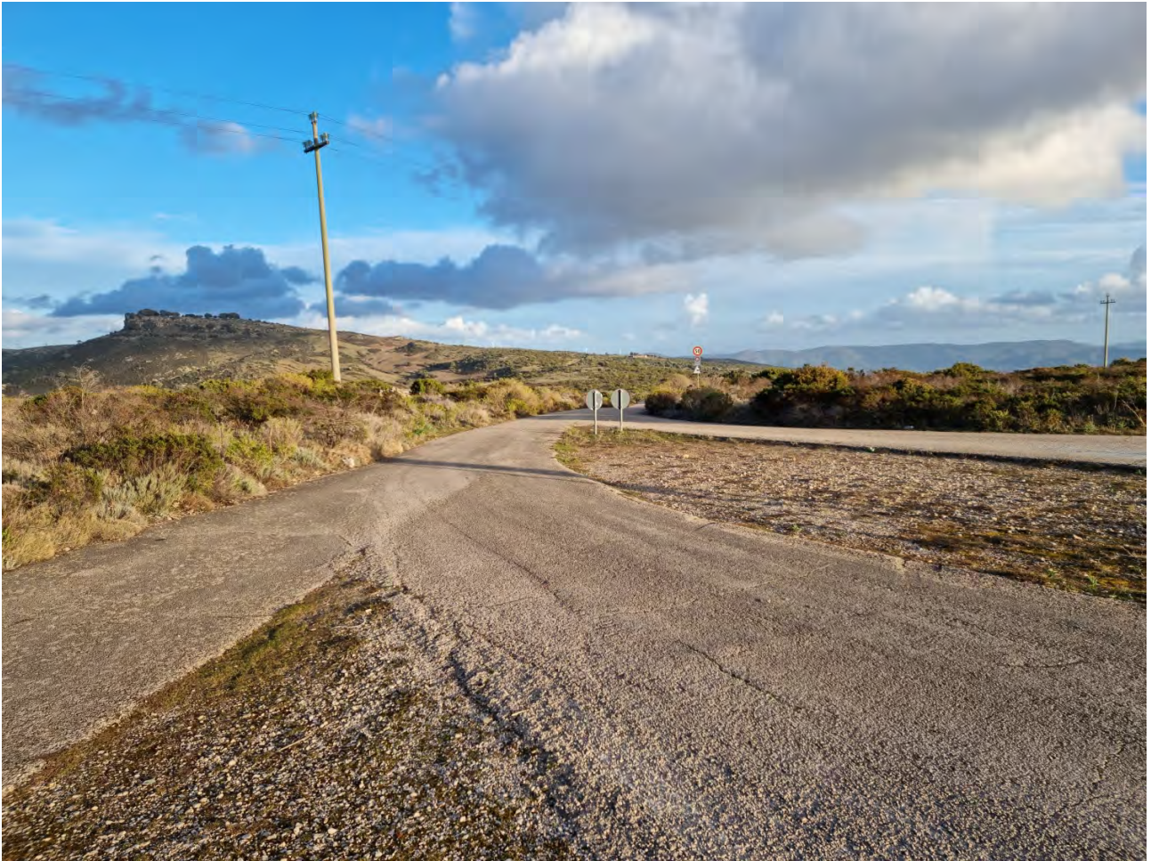
Figura 2.8: Vista verso sudest della zona proposta per le Turbine SE-11 ed SE-12
