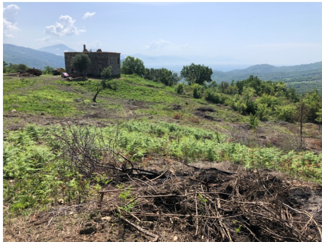
panoramica dell'area limitrofa al casolare
