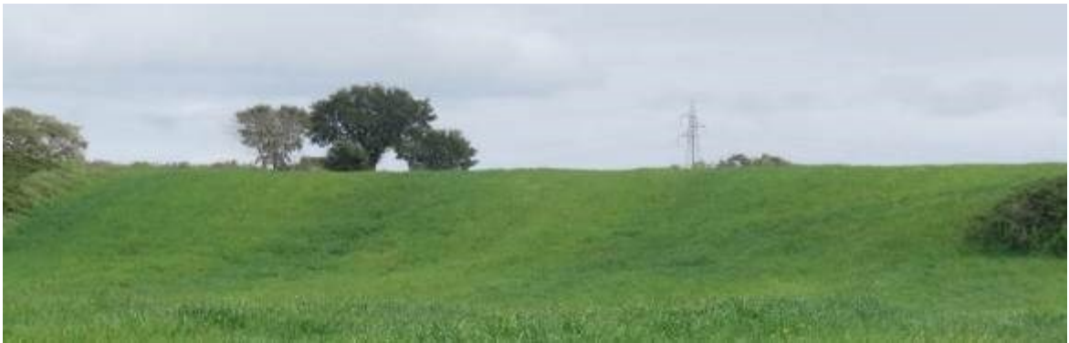
Figura 2-3: Settore nord ovest dell'impianto (WTG TUS1) caratterizzato da estesi seminativi e da rada vegetazione arborea.
