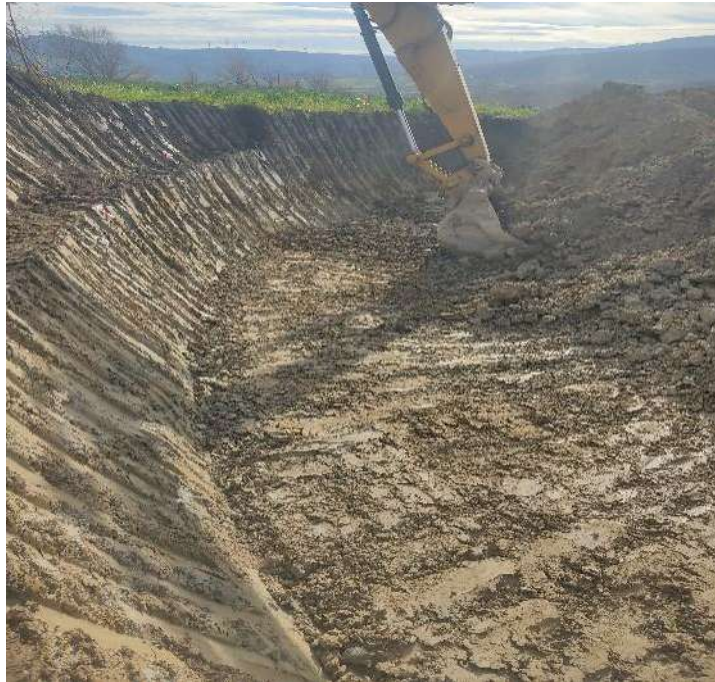
Figura 1. Attività di sbancamento della piazzola della torre A42. Veduta da E verso O
