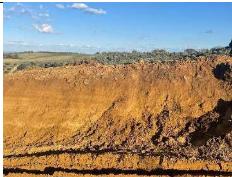
Sbancamento per scarpata con individuazione limite dispersione di materiale archeologico.
