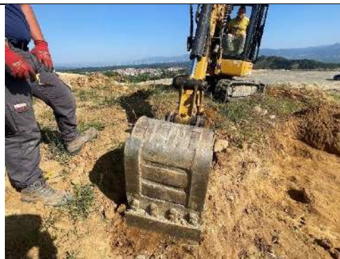
Avvio scavo con ausilio mezzo meccanico.
