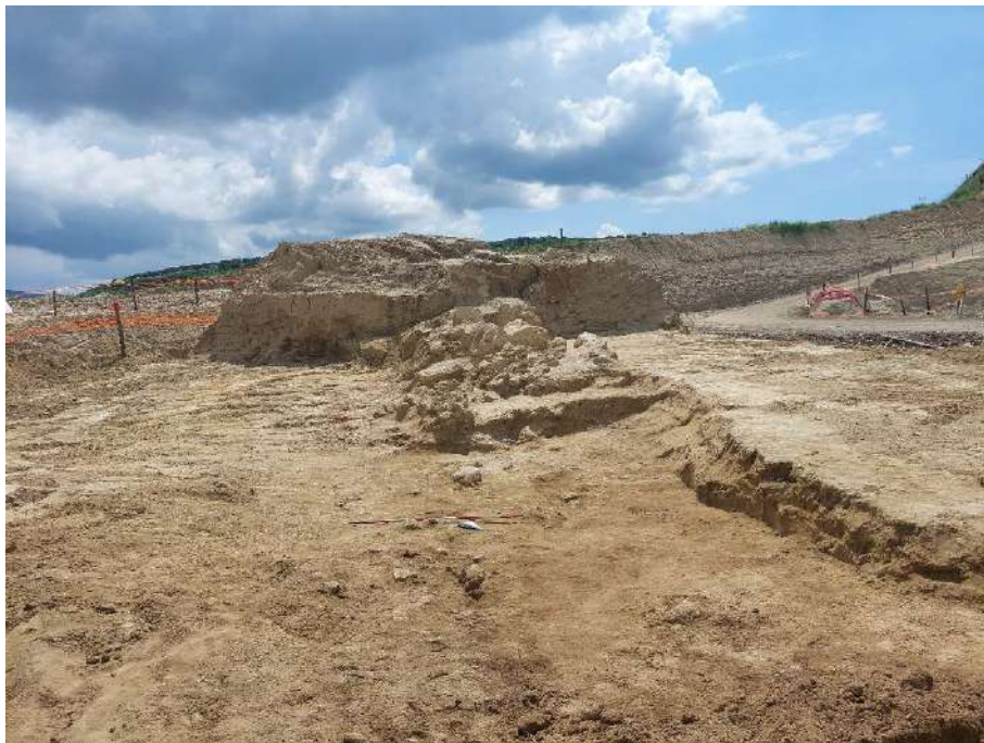
Figura 37. Veduta generale dell'area di scavo a termine delle lavorazioni, vista da N
