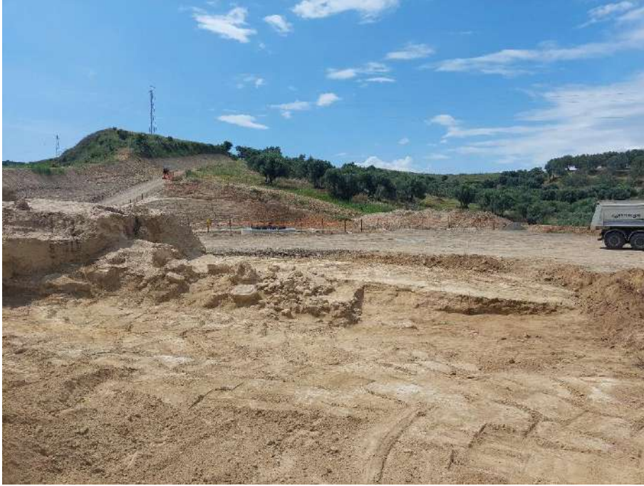
Figura 38. Veduta generale dell'area di scavo vista da E
