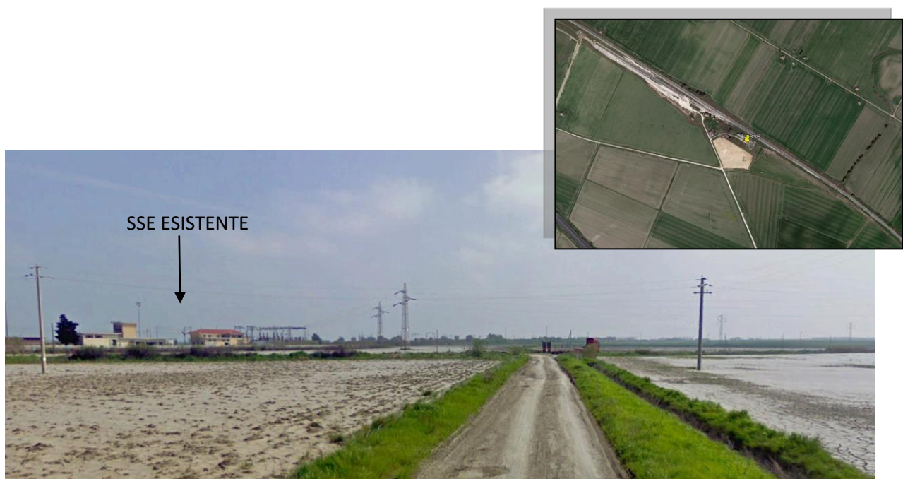
Figure 4-1 Attuale SSE di Ripalta, oggetto di rimodulazione dell'intervento in oggetto, nell'ambito agricolo
