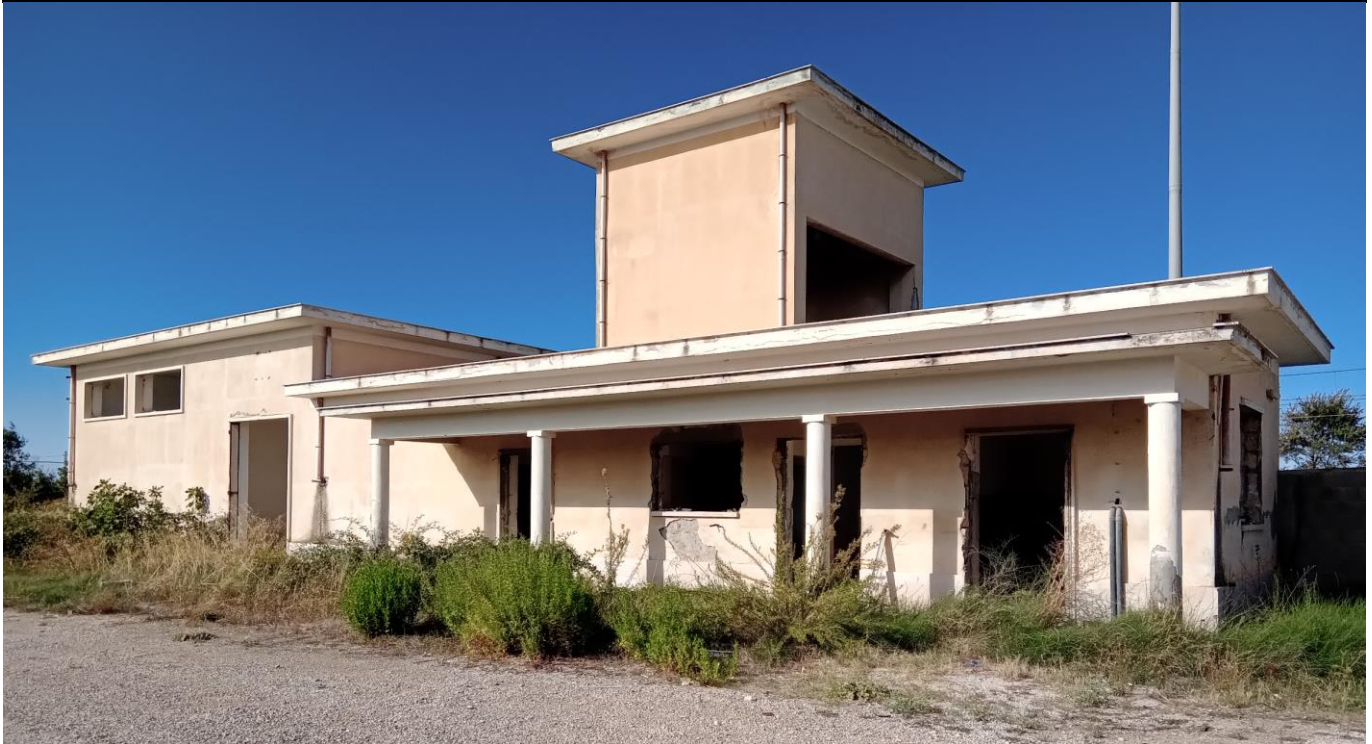
Figura 8: Fabbricato esistente da demolire
