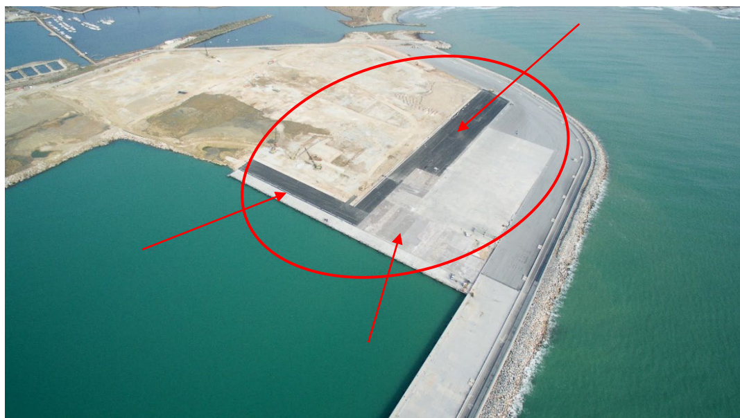
Fig. 6: Progettazione definitiva ed esecutiva, ed esecuzione degli interventi infrastrutturali anche a carattere ambientale in attuazione del nuovo P.R.P. per la realizzazione della banchina interna darsena Nord e relativo piazzale (foto stato attuale)
