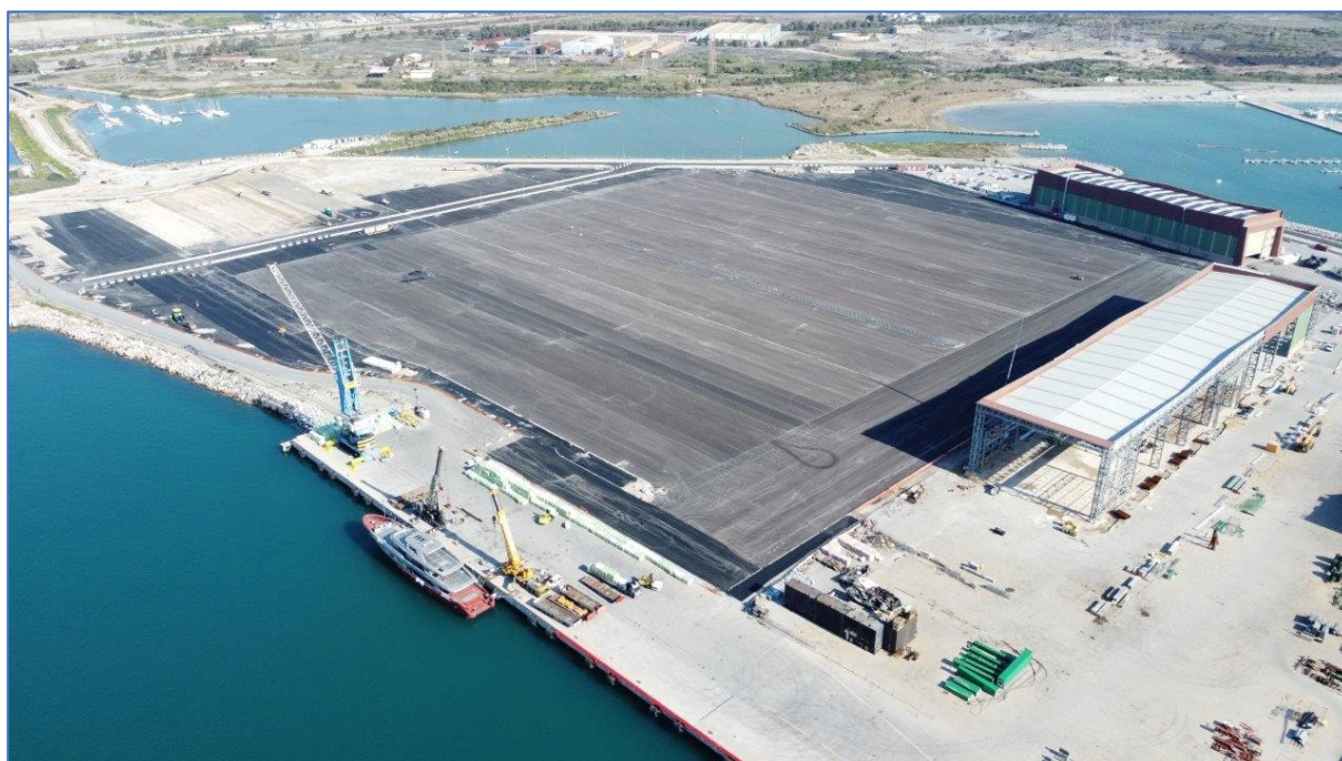
Fig. 9: Interventi connessi al Nuovo PRP e/o all'APQ del 13.08.2013 e all'APQ del 24.04.2014 per la realizzazione di un'area per la Logistica/Industriale nel porto di Piombino (situazione attuale)
