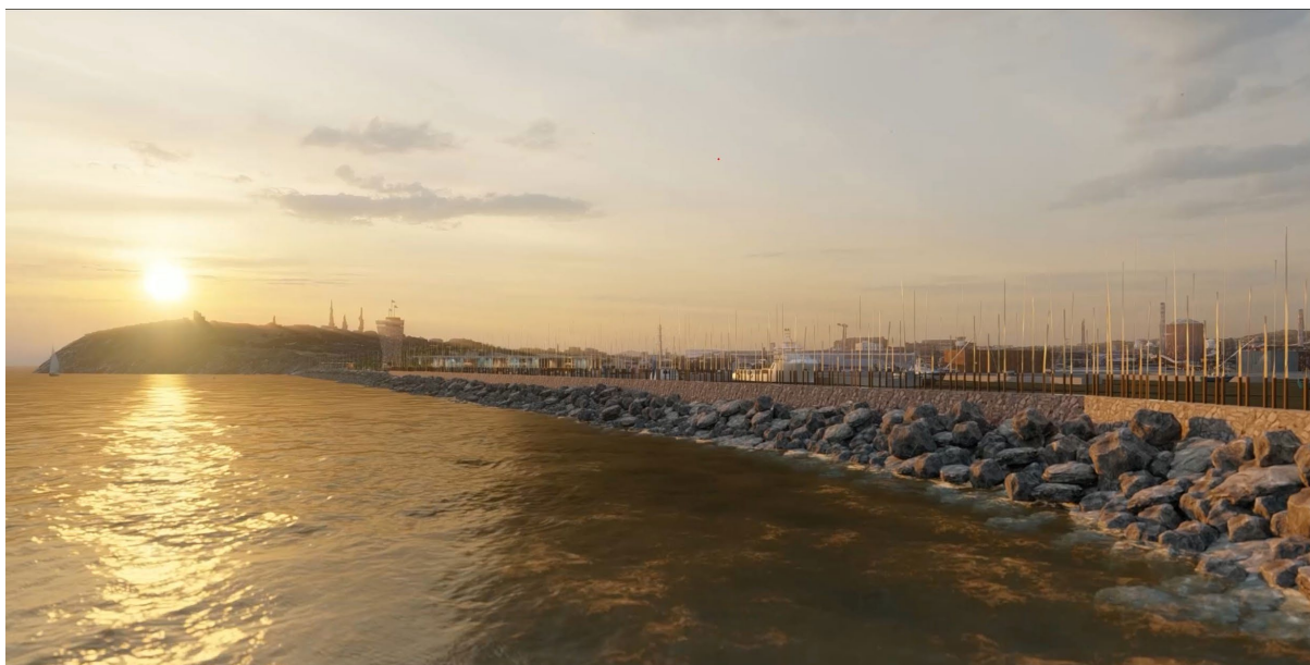
Fig. 16: Mitigazione ambientale del waterfront e di mitigazione paesaggistica dell'intera area del porto di piombino – Green energy impianto fotovoltaico porto di Piombino.
