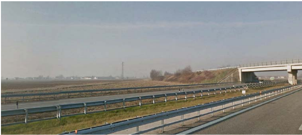
Figura 5 – Vista area di cantiere
