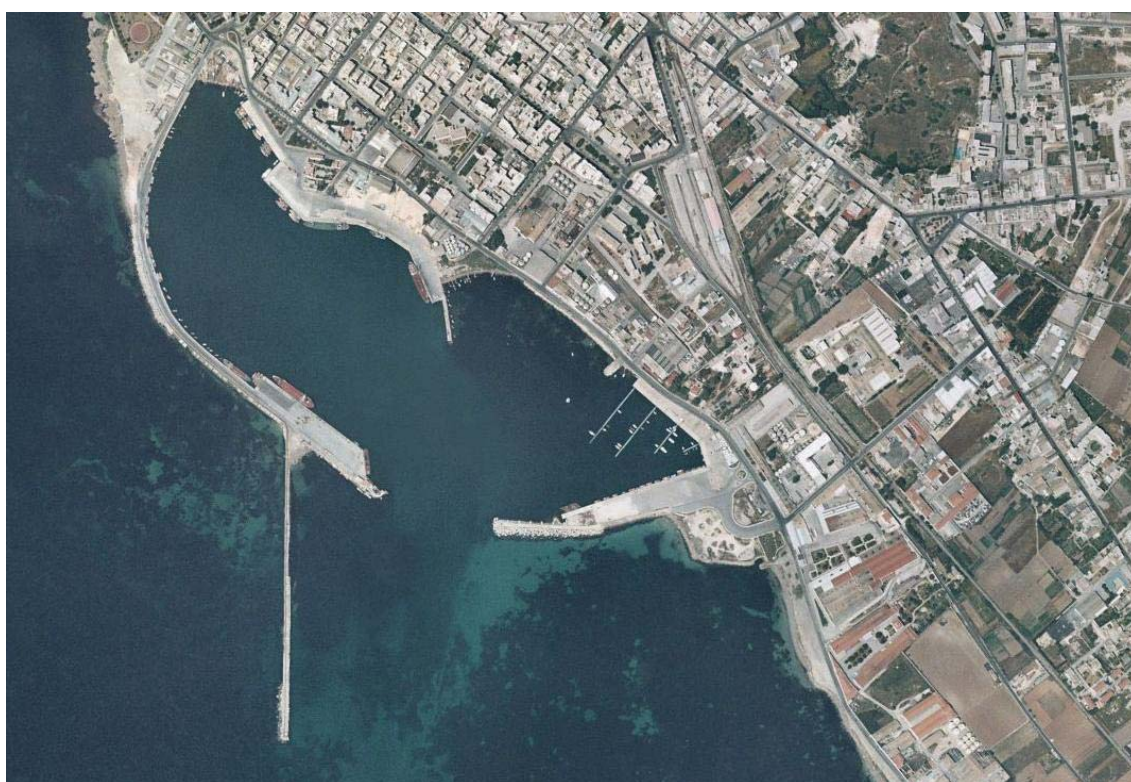
Figura 6 – Vista aerea del porto di Marsala
