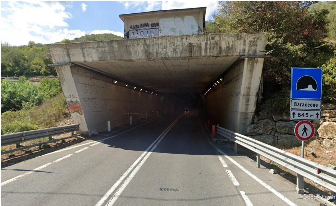
Uscite ed imbocco gallerie ove sarebbe indispensabile fresare l'asfalto ed abbassare il piano viabile di almeno 25 cm
