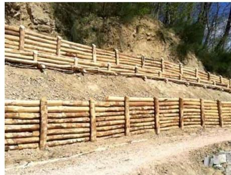
Figura 7 - esempio di palizzata
