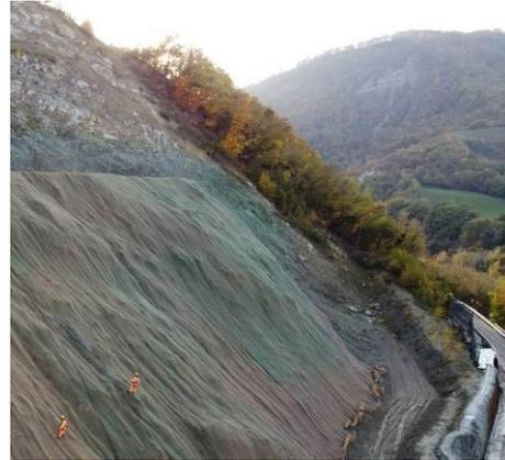
Figura 5 – sistema di applicazione idrosemina
