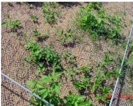
Figura 3 – particolare della vegetazione che cresce attraverso la biostuoia in cocco
