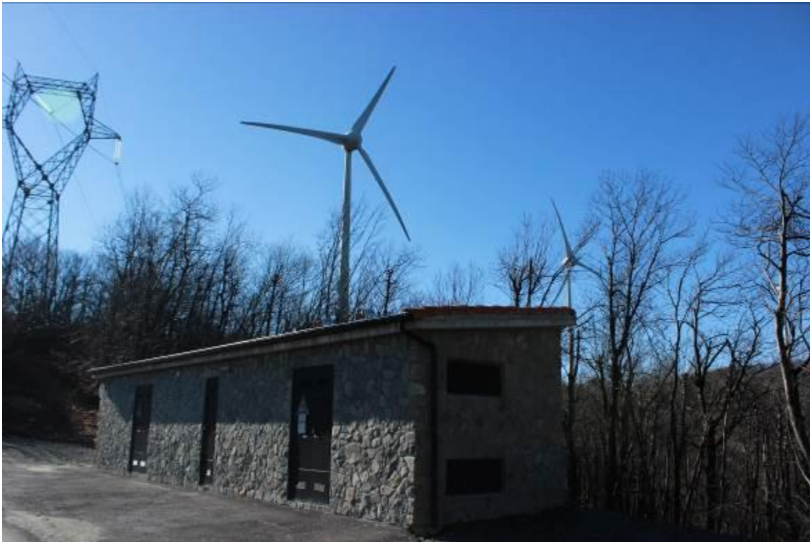
Figura 2 - esempio di mitigazione della sottostazione elettrica
