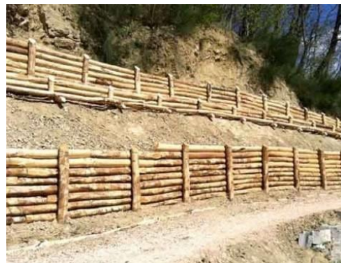
realizzazione di palizzata
