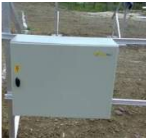
Figura 40 – QUADRI IN PARALLELO
