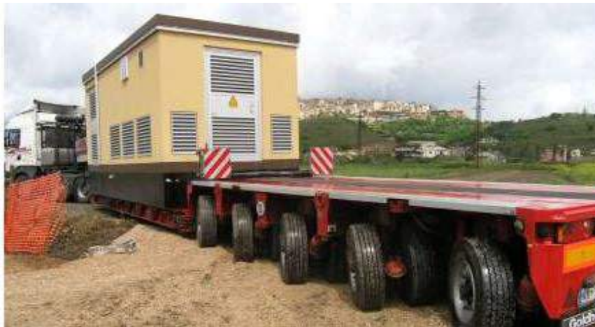
Figura 37– INSTALLAZIONE CABINE
