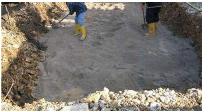
Figura 35 – SBANCAMENTO PIANO POSA CABINE
