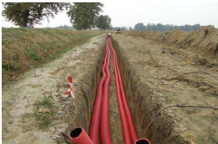
Figura 20: Scavo tipo per posa cavidotto.
