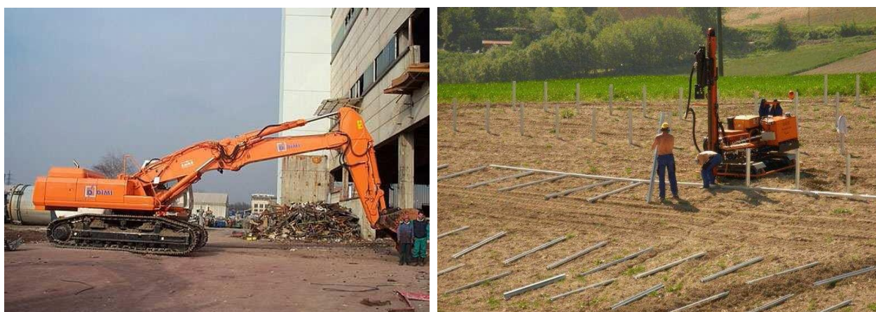
Figura 12: Esempi di macchine operatrici per la costruzione dell'impianto (Escavatore e macchina battipalo).
