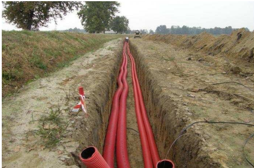
Figura 8: Scavo tipo per posa cavidotto.
