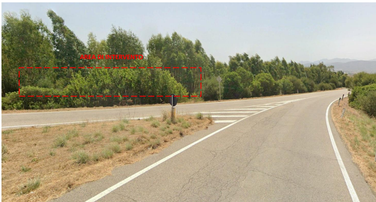
Figura 13: Vista da punto bersaglio 3M in direzione impianto AGV post-intervento.
