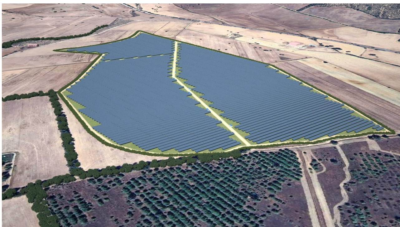
Figura 31: Vista A Post operam.
