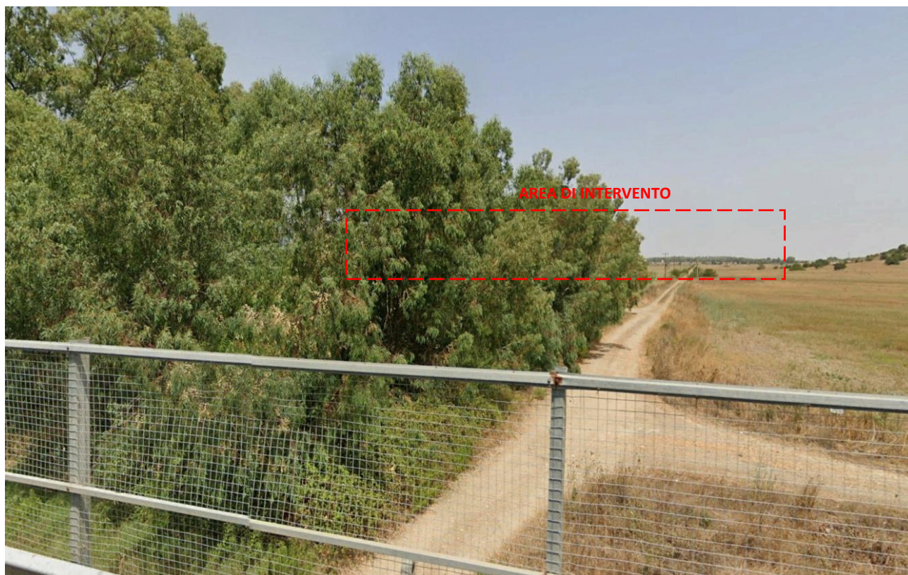
Figura 9: Vista da punto bersaglio 1M in direzione impianto AGV post-intervento.
