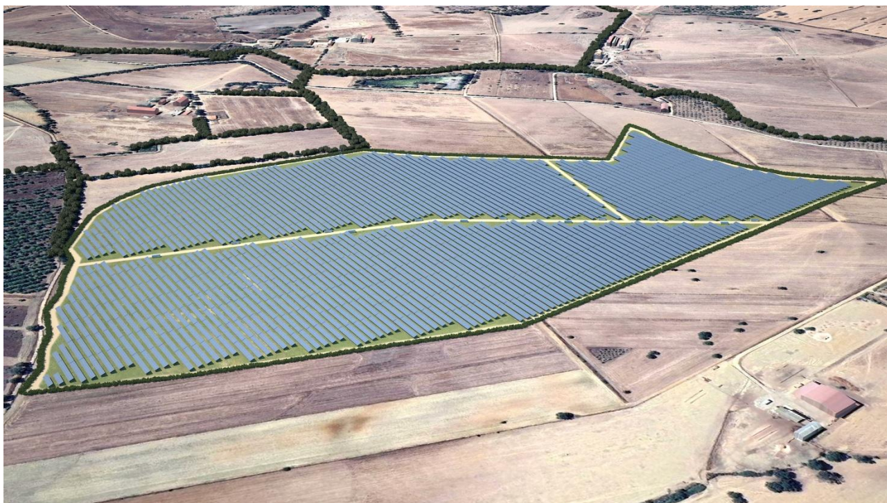
Figura 35: Vista C Post operam.
