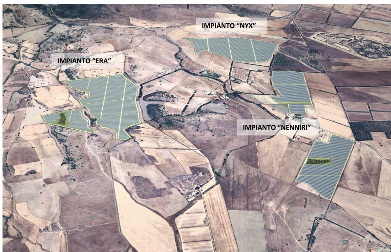
Figura 30: vista a volo di uccello su impianti "Era" - "Nyx" - "Nenniri" _vista direzione Nord.
