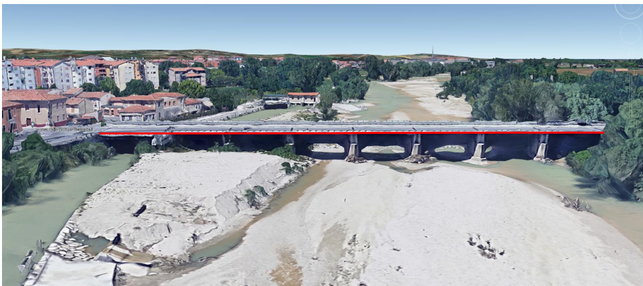
(3) staffaggio sulla soletta in cemento armato (simulazione caso in esame)
