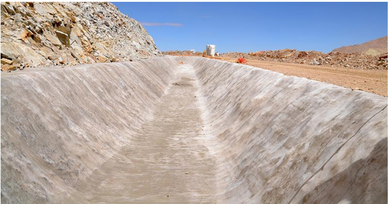
Figura 28 - Esempio di fossa di guardia in terra
