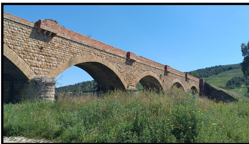
Figura 4 - foto dell'impluvio costituente l'interferenza "Int 4"
