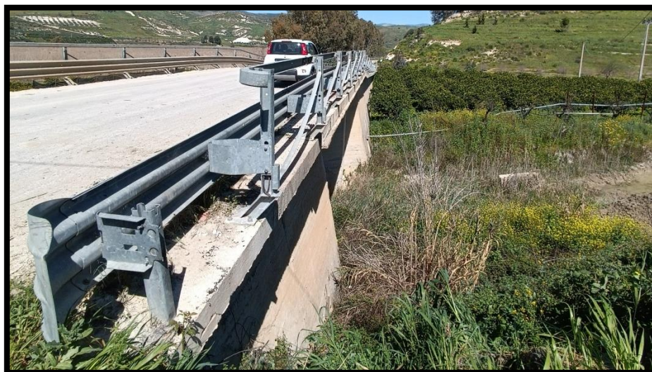
Figura 5 - foto dell'impluvio costituente l'interferenza "Int 5"
