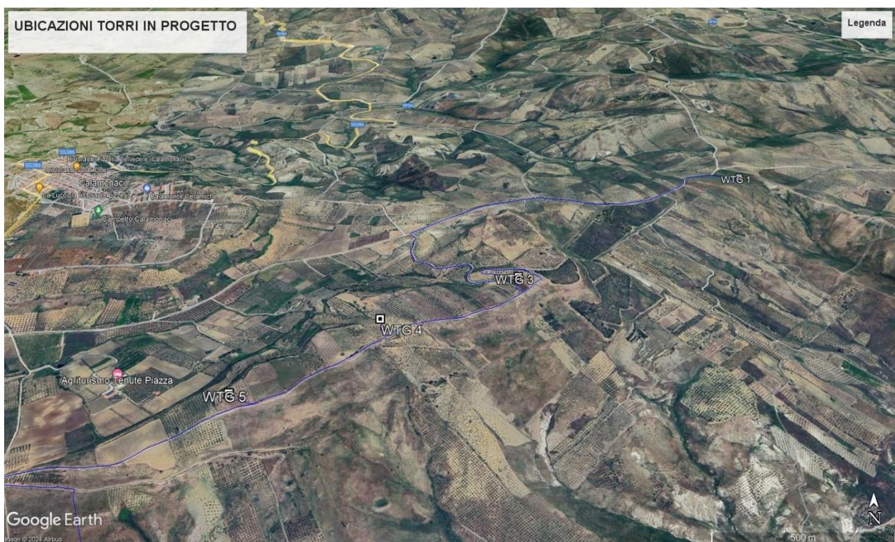
Figura 1 – Ubicazione delle torri eoliche
