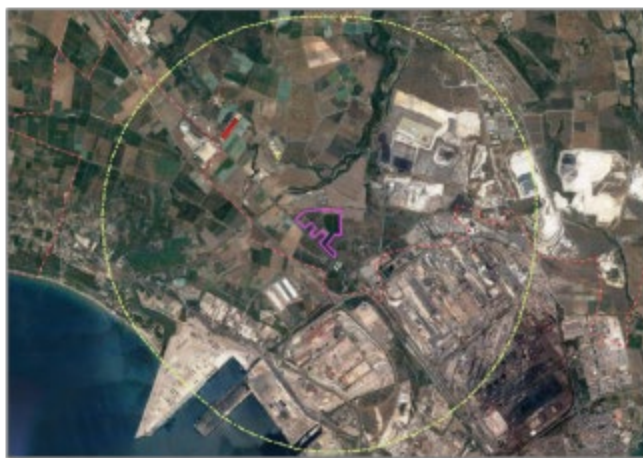
Figura 5 – Impianti fotovoltaici presenti nella zona di impianto
