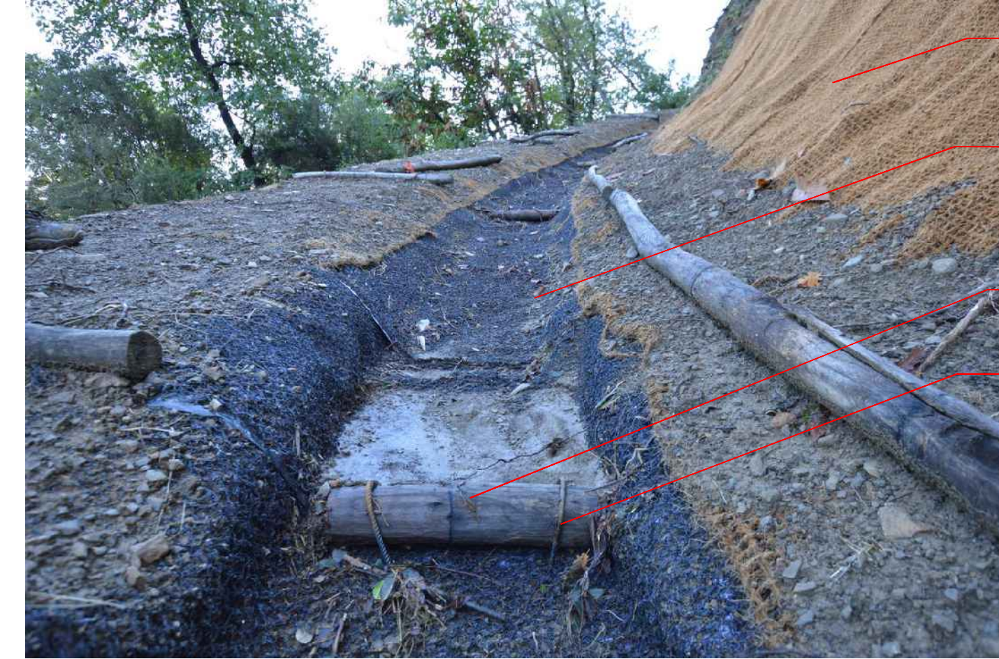
Particolare trincea drenante - Scala 1:20
