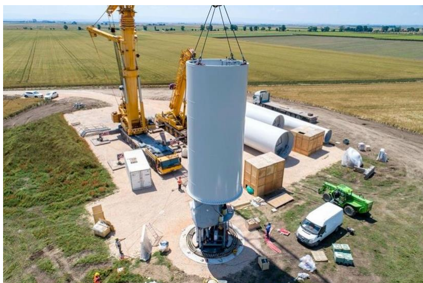
Figure 16 - fissaggio al basamento della fondazione
