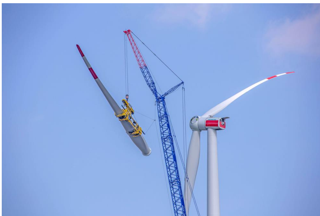
Figure 18 – Montaggio pale attraverso la gru Liebherr LR 1600 2W
