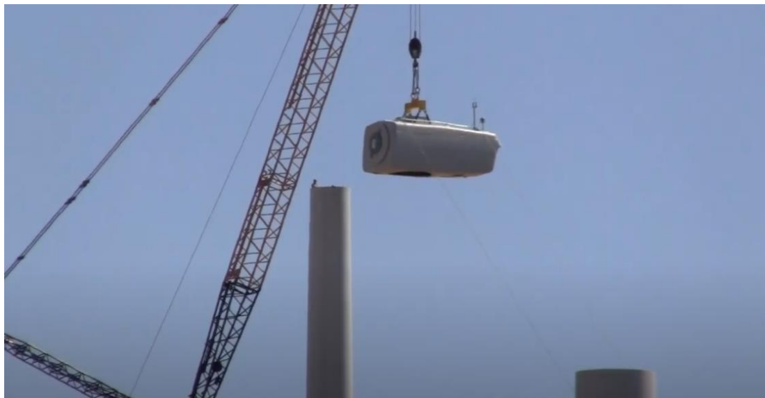
Figure 17 - Installazione navicella
