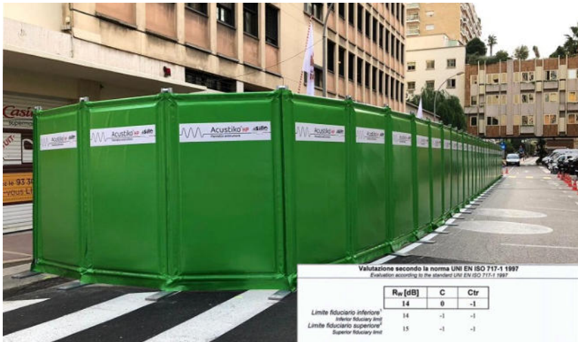
Figura 20: Caratteristiche tecniche e dati di abbattimento della barriera antirumore temporanea di cantiere
