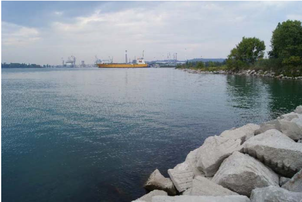
Figura 4.q: Vista dell'Area di Accosto Verso Nord – Ovest
