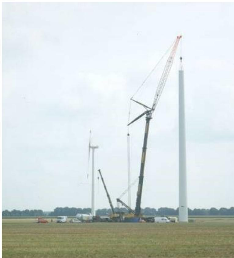
*Figura 67 Montaggio secondo troncone torre*
