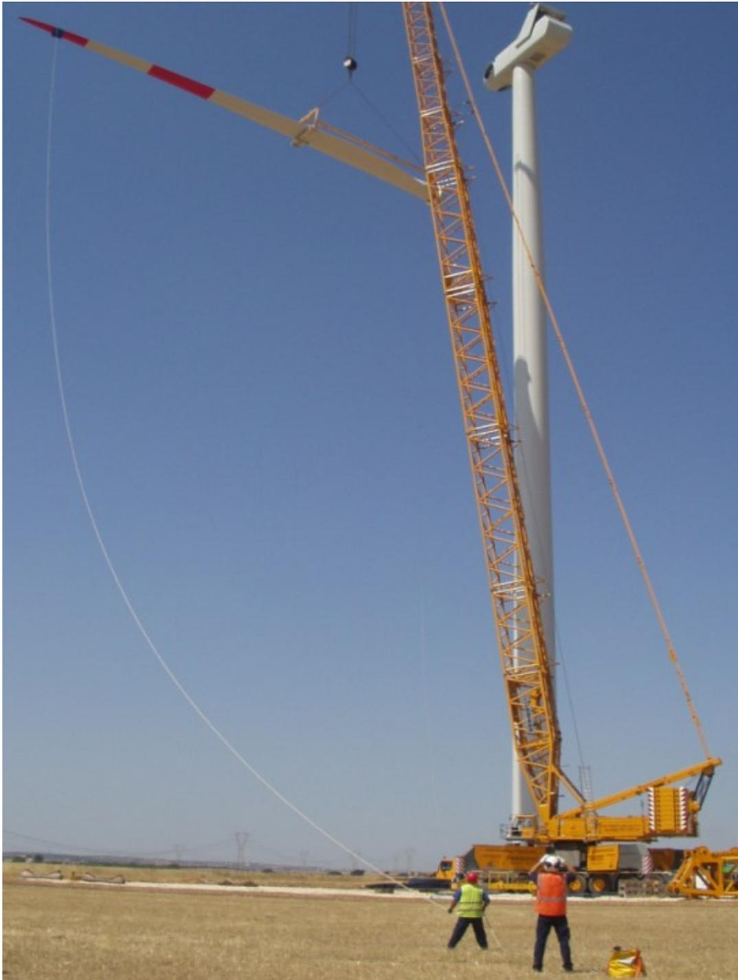
*Figura 72 Montaggio pala*
