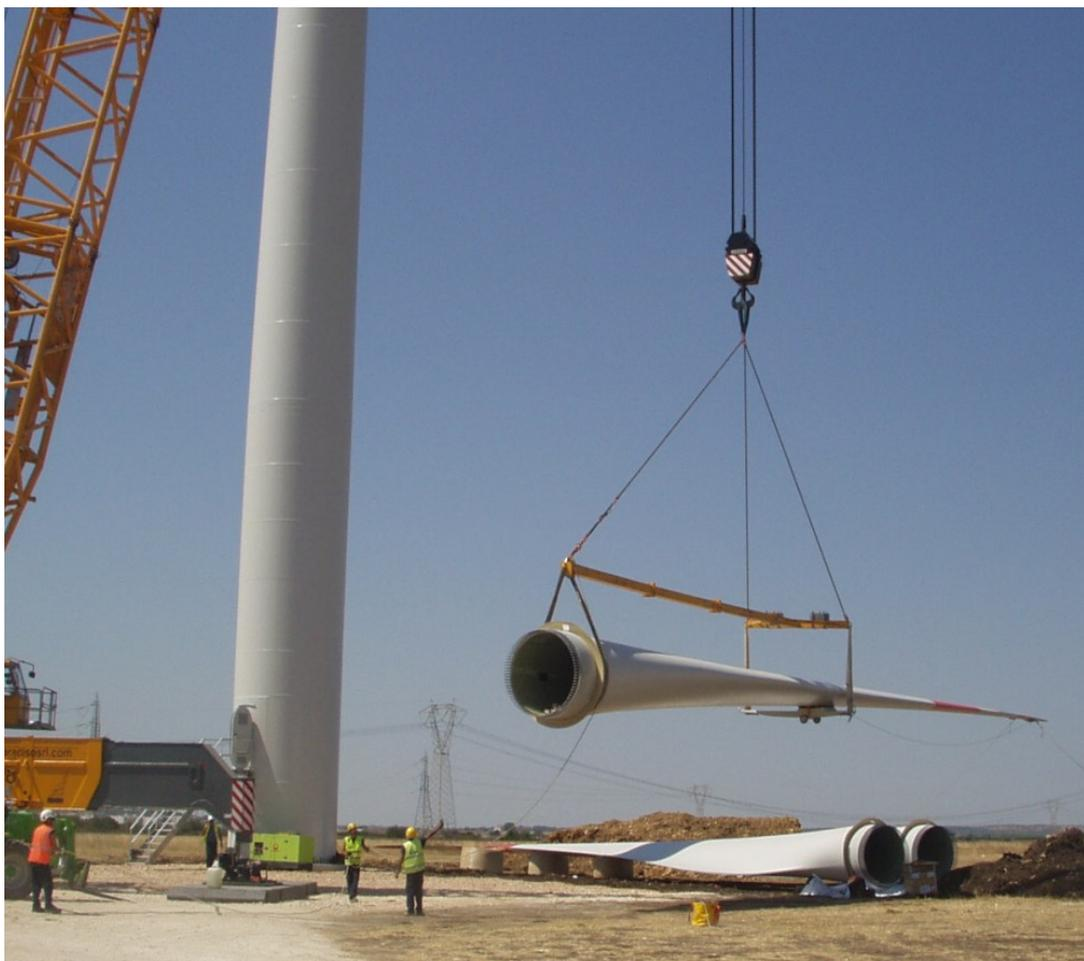
*Figura 71 Montaggio pala*
