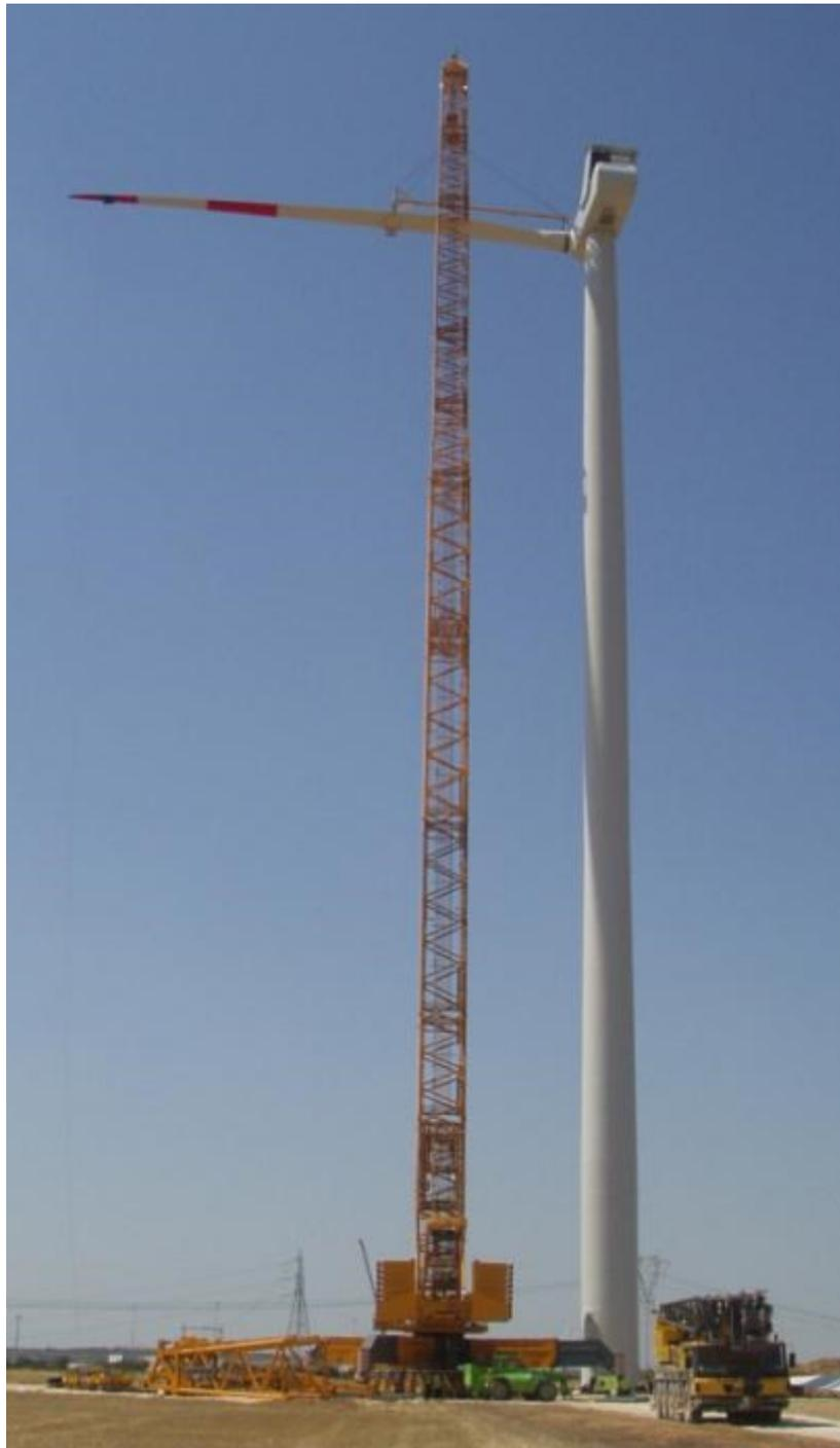
*Figura 73 Montaggio pala*
