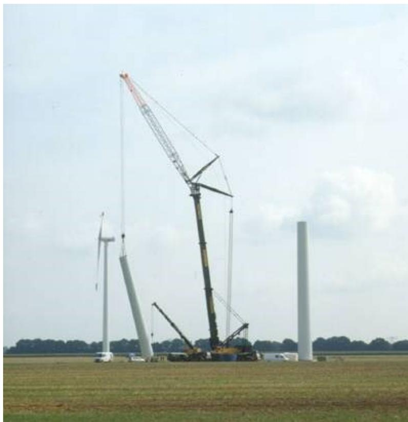
*Figura 65 Montaggio secondo troncone torre*
