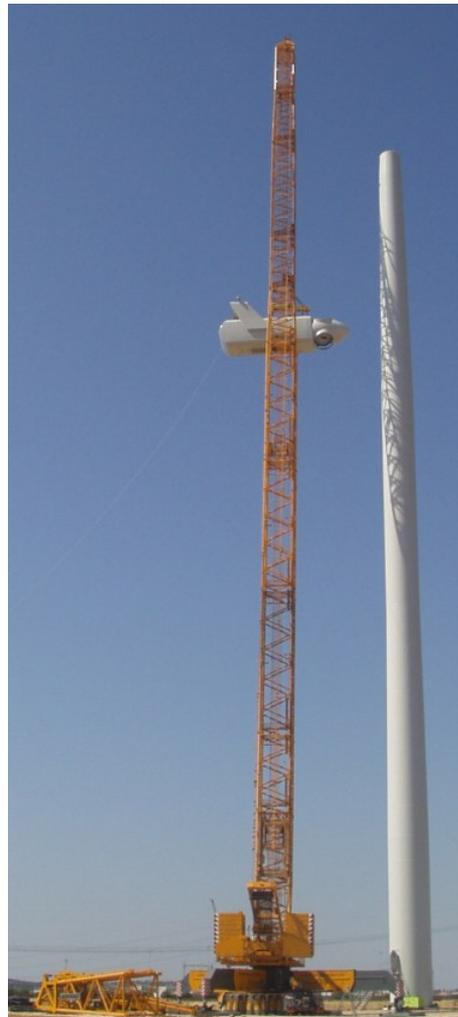
*Figura 69 Montaggio Navicella*
