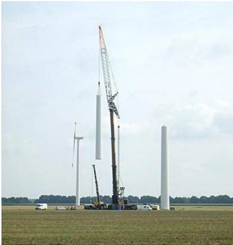
*Figura 66 Montaggio secondo troncone torre*
