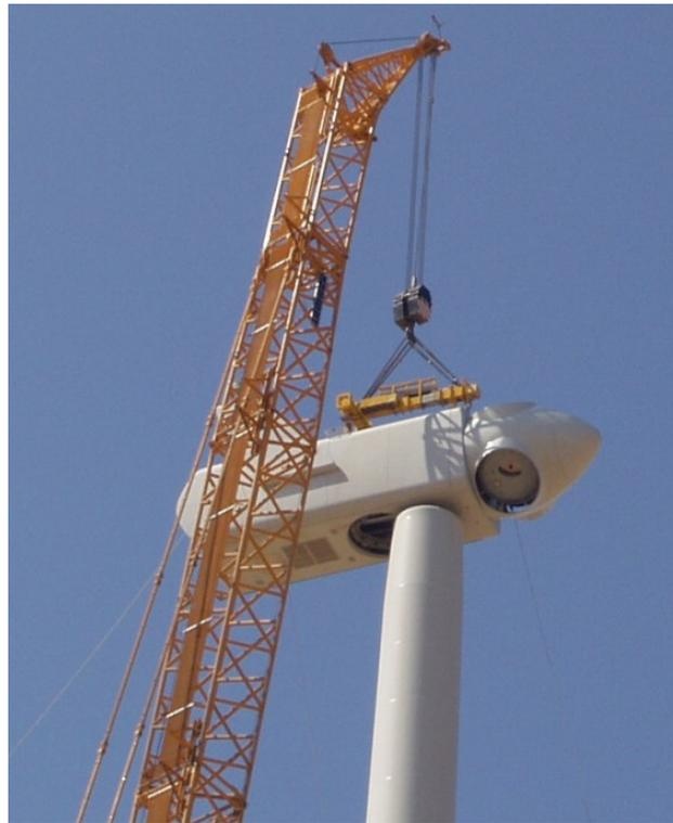
*Figura 70 Montaggio Navicella*
