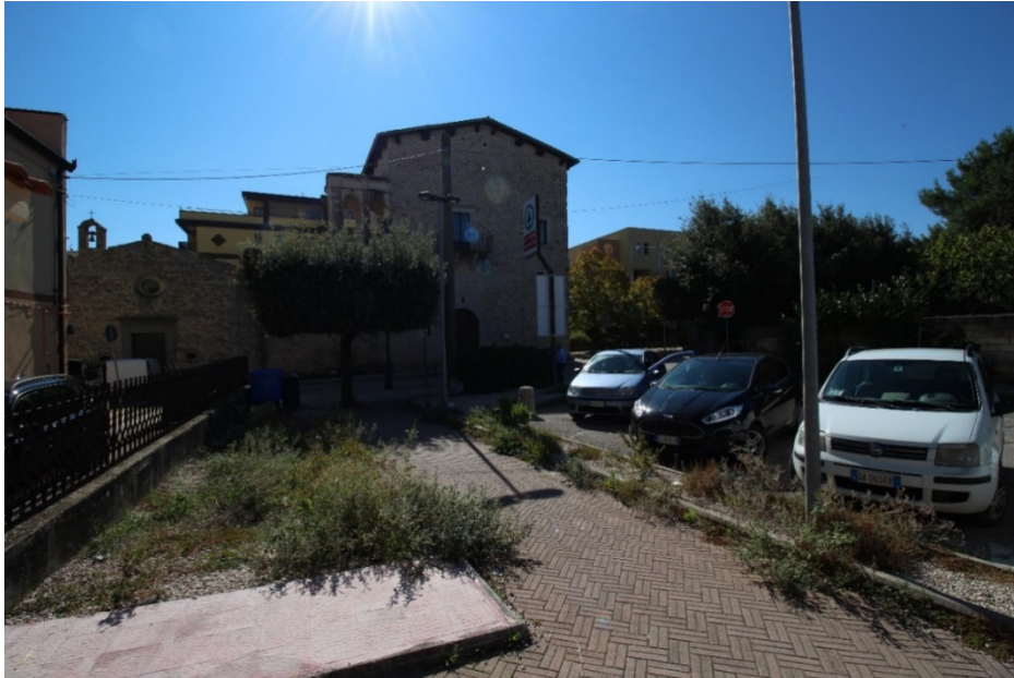
Scatto 13_Vista frontale Palazzo La Torre – Ante operam = Post operam
