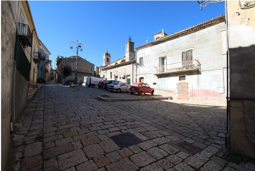
Scatto 7_Vista da Palazzo Colombo – Ante operam = Post operam
