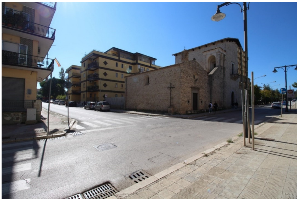
Scatto 14_Vista laterale Palazzo La Torre – Ante operam = Post operam
