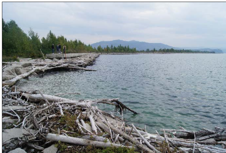
3 - Scogliera di massi a protezione della colmata
