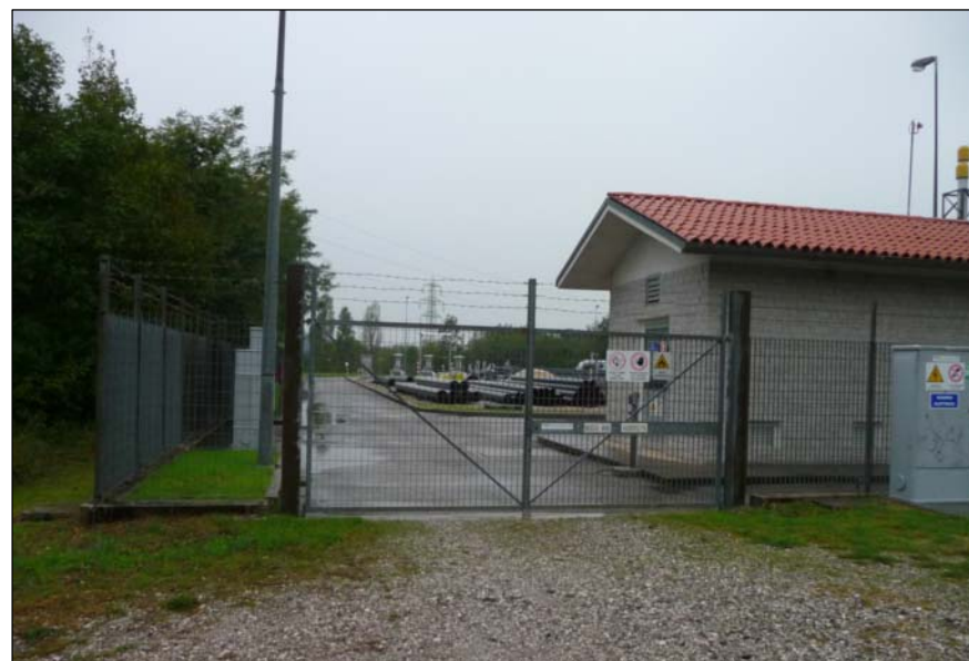
2 - Stazione SNAM Rete Gas (Nodo No. 899) ingresso
