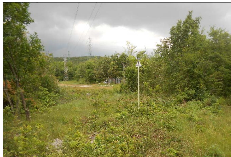
6 - Vista su area stazione di intercettazione
