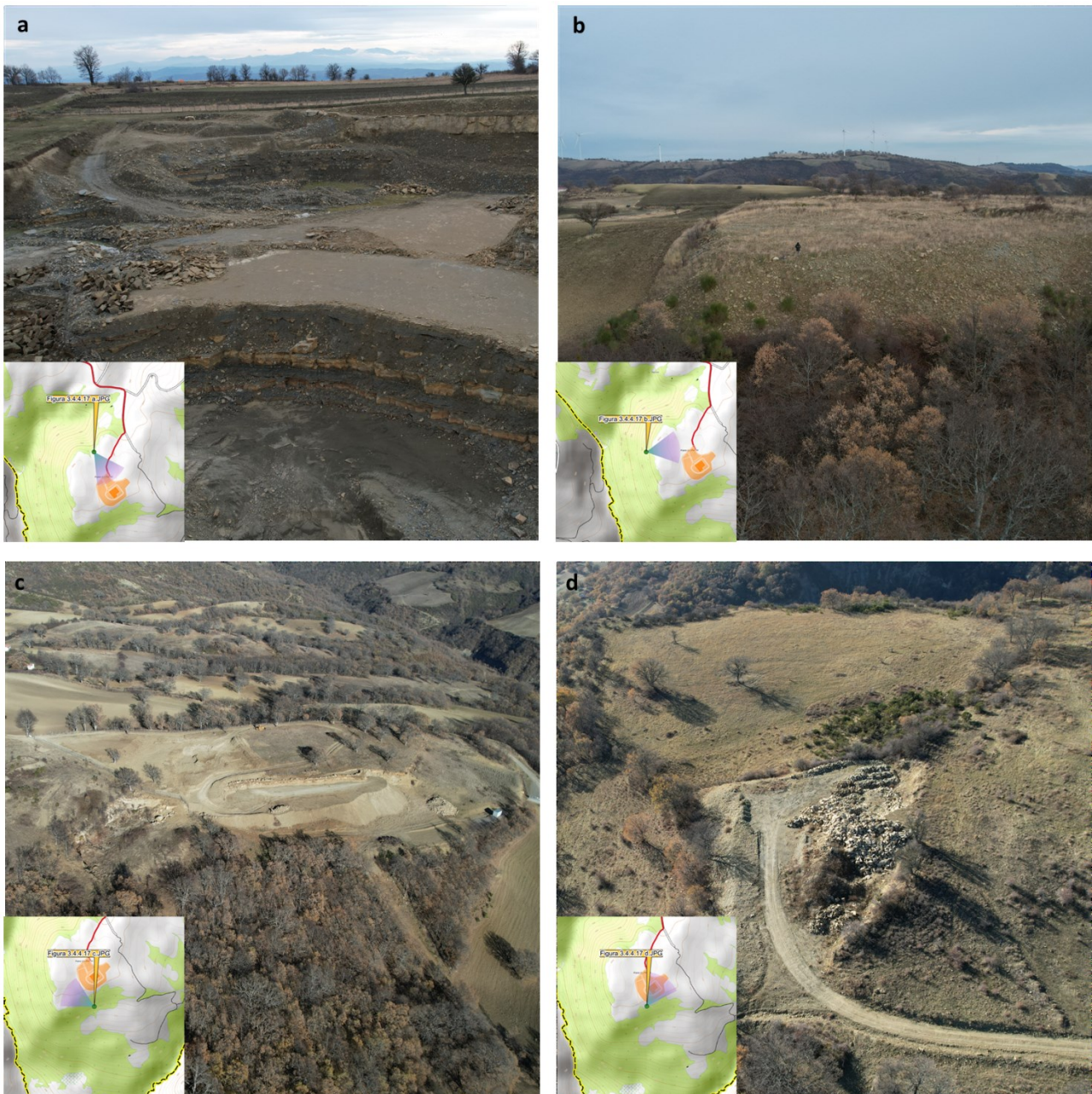
Figura 3.3.4.17 - a) Cava Alianelli; b) Rilevato antropico costituito da scarti di cava parzialmente rivegetata posto a margine del versante occidentale con piccoli fenomeni di “soil slip”; c) Cava Toce; d) Pietraia con piazzale impostato su terreno di riporto. In basso a sinistra è riportato il riquadro mostrante il punto di osservazione.
